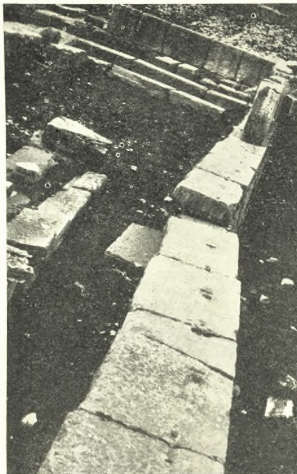
Εἰκ. 62. Ἡ Ἄν. πλευρὰ τοῦ ἐξωτερικοῦ τοίχου. Περὶ τὸ μέσον εἶναι ὀρατὴ ἡ καθίζησις τοῦ τοίχου ἕνεκα τῆς ὑπ' αὐτὸν μεγάλης ὀπῆς.
