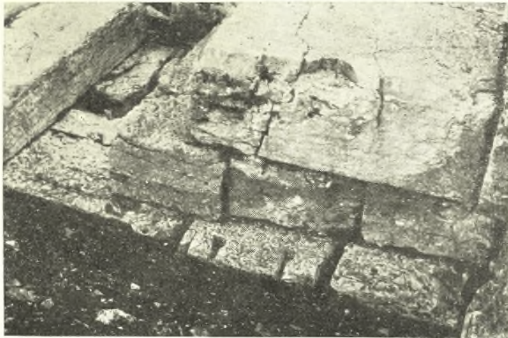
Εἰκ. 26. Τμήμα τῆς δυτικῆς πλευρᾶς τοῦ ἑλληνιστικοῦ ναοῦ, ὑπὸ τὸ ὁποῖον εἶναι ὄρατὴ ἡ νεώτερα προσθήκη τοῦ θεμελίου.
