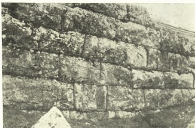
Εἰκ. 3. Τμήμα τείχους τῆς νοτίας πλευρᾶς τῆς ἀκροπόλεως.
