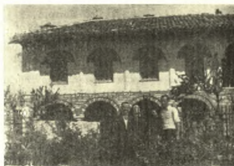
Εἰκ. 25. Ἡ ἐπισκευασθεῖσα νοτία πλευρὰ τοῦ Μενδρεσέ τῶν Ἰωαννίνων.
