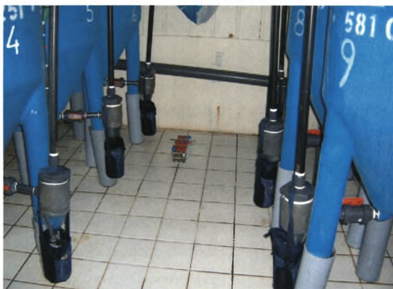
Εικόνα 3.1β. Σύστημα συλλογής περιττωμάτων με εμβαπτιση σε πάγο
