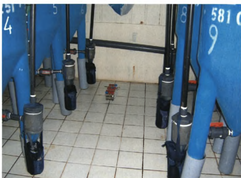
Εικόνα 3.1β. Σύστημα συλλογής περιττωμάτων με εμβάπτιση σε πάγο
