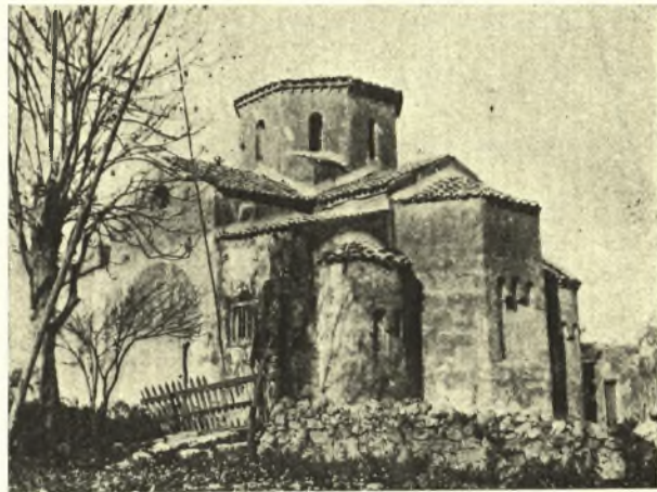
Εἰκ. 22. Νοτιανατολικὴ ἀπομικρὸς τοῦ ναοῦ πρὸ τῶν ἐπισκευῶν.
