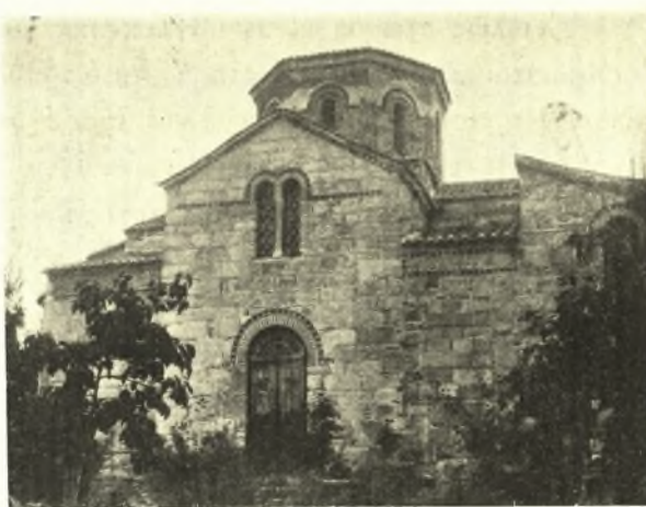
Εἰκ. 15. Βορεία πλευρὰ τοῦ ναοῦ μετὰ τὰς ἐπισκευάς.
