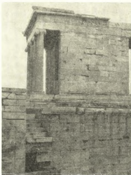
Εἰκ. 24. Βόρειος πλευρὰ τοῦ πύργου. Κλίμαξ.
