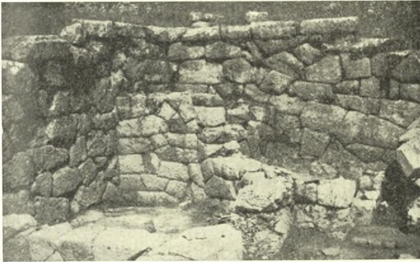
Εἰκ. 2. Ἡ ΒΔ. γωνία τοῦ οἰκοδομήματος μετὰ τὴν ἀναλημματικὴν τετράγωνον κατασκευὴν ἐσωτερικῶς.
