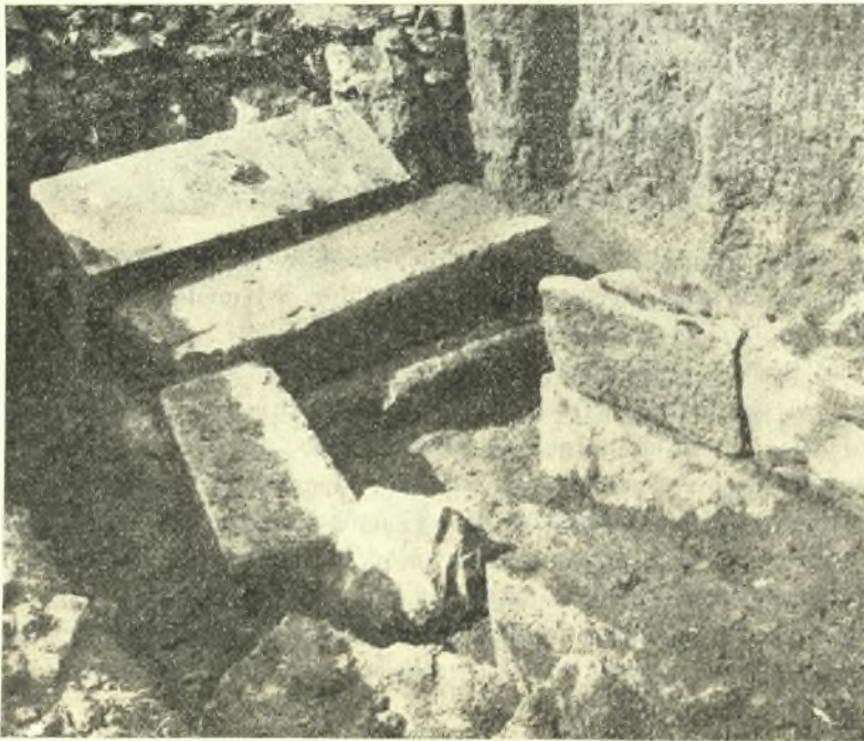
Εἰκ. 7. Τμήμα ταφικοῦ οἰκοδομήματος 15 μ. ἀνατολικῶς τοῦ θολωτοῦ μνημείου.
