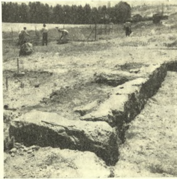
Εἰκ. 3. Θεμέλια κτίσματος παρὰ τὸ λιθοτριβεῖον Κριεκούκη.
