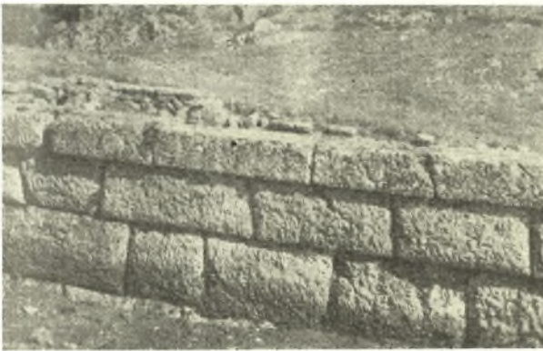
Εἰκ. 9. Τὸ ἀνατολικὸν τμῆμα τῆς νοτίας προσόψεως τοῦ οἰκοδομήματος με προέχοντα τὸν ἀνώτερον δόμον.
