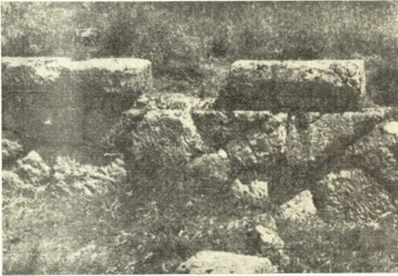
Εἰκ. 22. Ἐσωτερικὴ ὄψις τοῦ βορείου τοίχου. Ἡ ὀριζοντία λάξευσις δεικνύει τὴν θέσιν στηρίξεως τῶν δοκῶν διὰ τὸ δάπεδον τοῦ ἄνω ὀρόφου.
