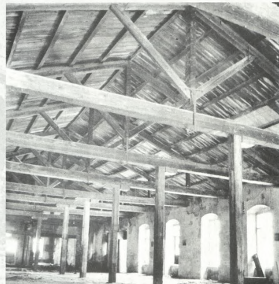
Εργοστάσιο «Πρωτόπαπα» μεταξύ 1900 – 1906, Πειραιάς. Αποψη του εσωτερικού χώρου του Α' ορόφου.
