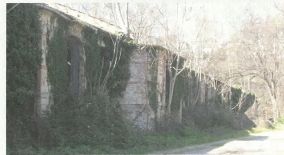
Το κτίριο παραγωγής στη σημερινή του κατάσταση.
