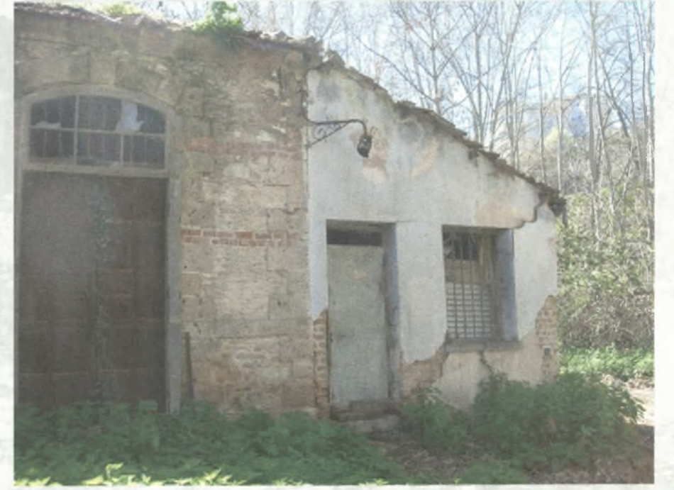
Α. ΚΤΙΡΙΟ ΠΑΡΑΓΩΓΗΣ
