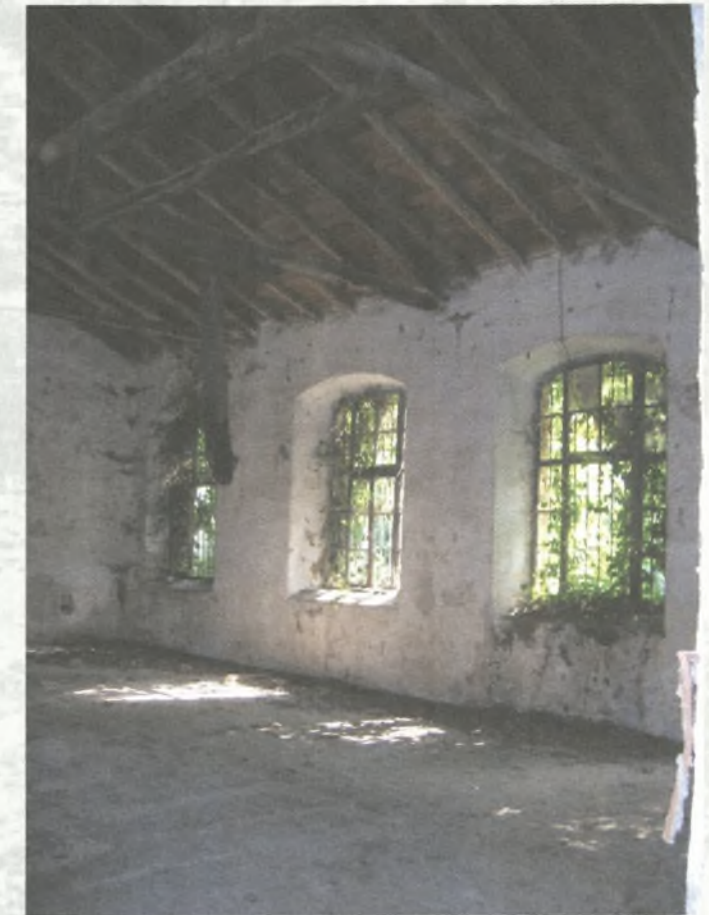
Α. ΚΤΙΡΙΟ ΠΑΡΑΓΩΓΗΣ
