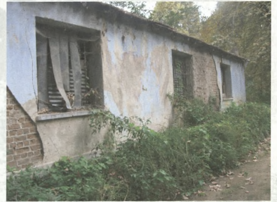
Α. ΚΤΙΡΙΟ ΠΑΡΑΓΩΓΗΣ
