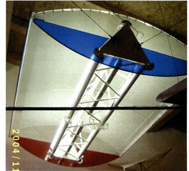
4. Λεπτομέρεια ενσωμάτωσης λαμπτήρα στο εσωτερικό της περσίδας
