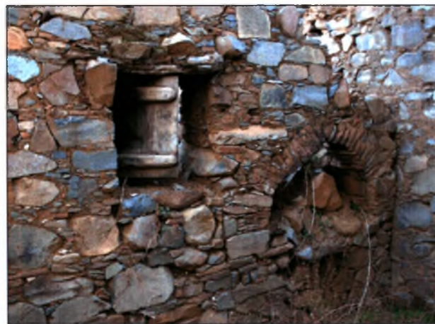
Εικόνα 37 : Εσωτερικός φούρνος. Οικία Μιχαηλίδη Κ.
