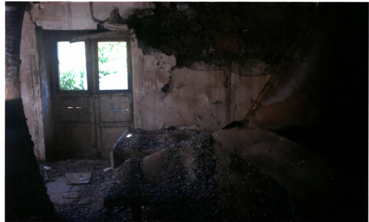
Εικόνα 87 : Τα κουφώματα έχουν υποστεί γήρανση, έχουν παραμορφωθεί από την αυξημένη άσκηση κατακόρυφων φορτίων, ενώ μέρος τους έχει παρουσιάσει μερική αποσάθρωση ξυλείας.
