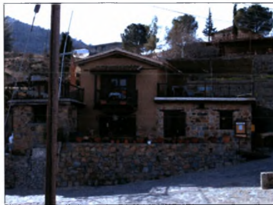
Εικόνα 10 : Καφενείο Γιαννακού, μετά την αποκατάσταση
