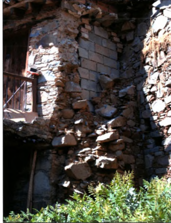
Εικόνα 63 : Τρόπος σύνδεσης που υπάρχει μεταξύ οικίας Χαραλάμπους και οικίας Ζαχαρίου.
