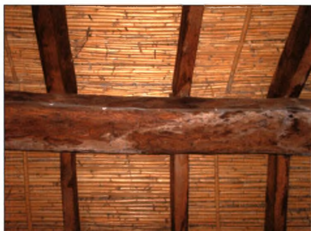
Εικόνα 49 : Νεύκα- δοκός, βολιτζια-δοκάρια και καλάμια. Οικία Χαραλάμπους χ.
