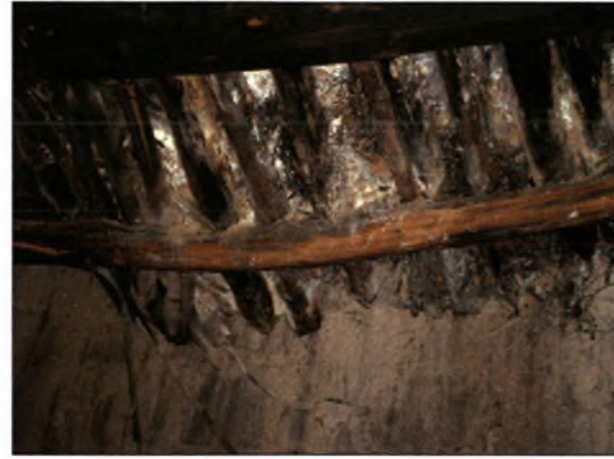
Εικόνα 84 : Θραύση φερόντων στοιχείων και σε ένα σημείο απόκλιση από την οριζόντιο του δαπέδου του ορόφου.
