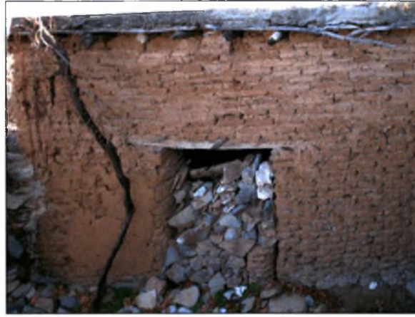
Εικόνα 74 : Η επικάλυψη έχει αποκολληθεί.
