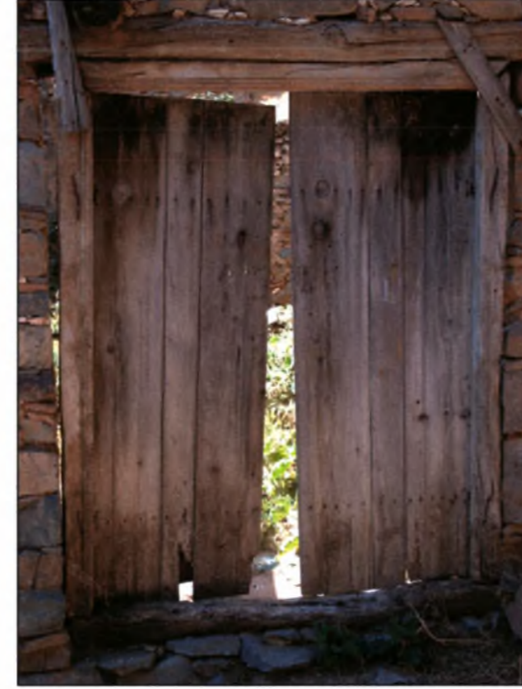
Εικόνα 96 : Οι θύρες έχουν υποστεί γήρανση, και το κάτω μέρος τους παρουσιάζει μερική αποσάθρωση ξυλείας.
