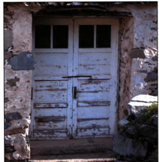
Εικόνα 57 : Ταμπλαδωτή σε όροφο με ανοίγματα στο πάνω μέρος. Οικία Ζαχαρίου Α.
