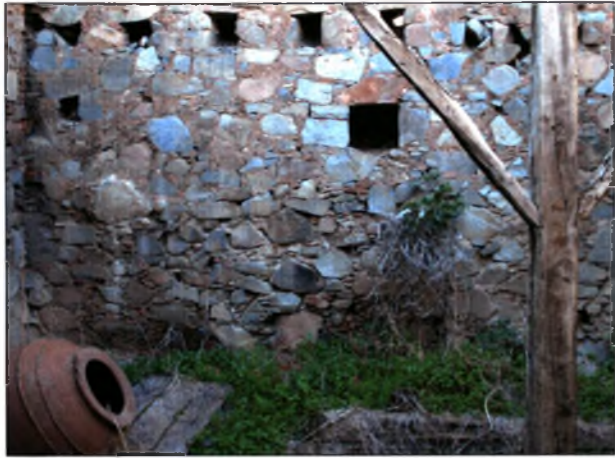
Εικόνα 33 : Εσωτερικός αποθηκευτικός χώρος. Οικία Μιχαηλίδη Κ.
