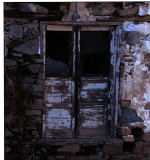
Εικόνα 58 : Ταμπλαδωτή σε όροφο με ανοίγματα στο πάνω μέρος. Οικία Ζαχαρίου Α.
