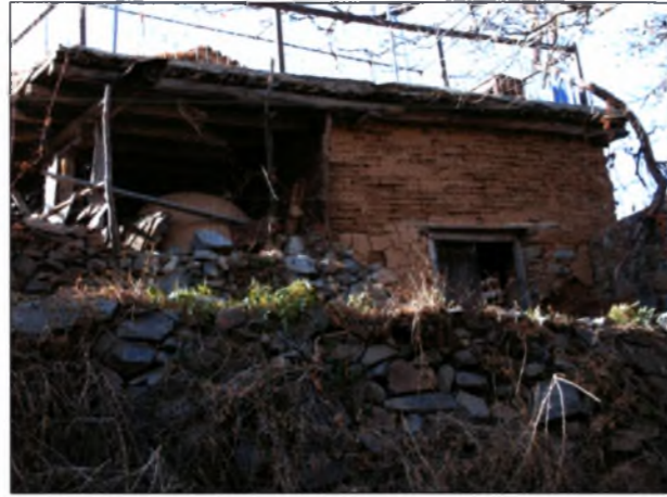
Εικόνα 34 : Πρόκτισμα σε άμεση επαφή με τον δρόμο. Οικία Χαραλάμπους Χ.
