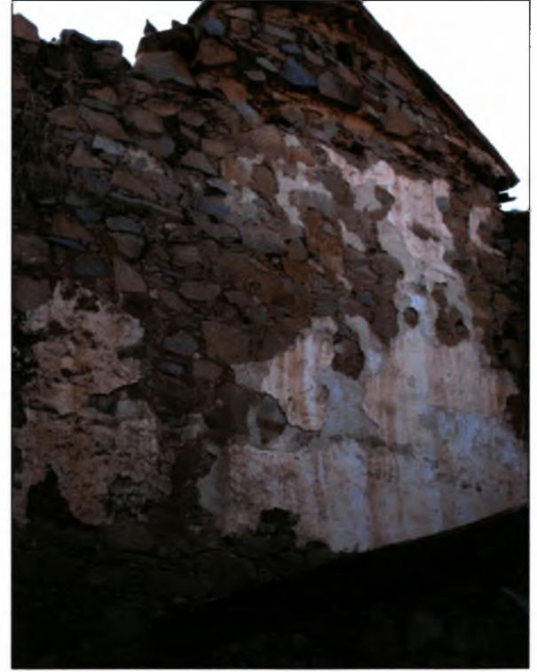
Εικόνα 99 : Καταστραμμένη επικάλυψη
