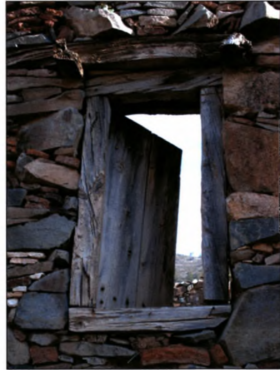
Εικόνα 95 : Γήρανση ξυλείας
