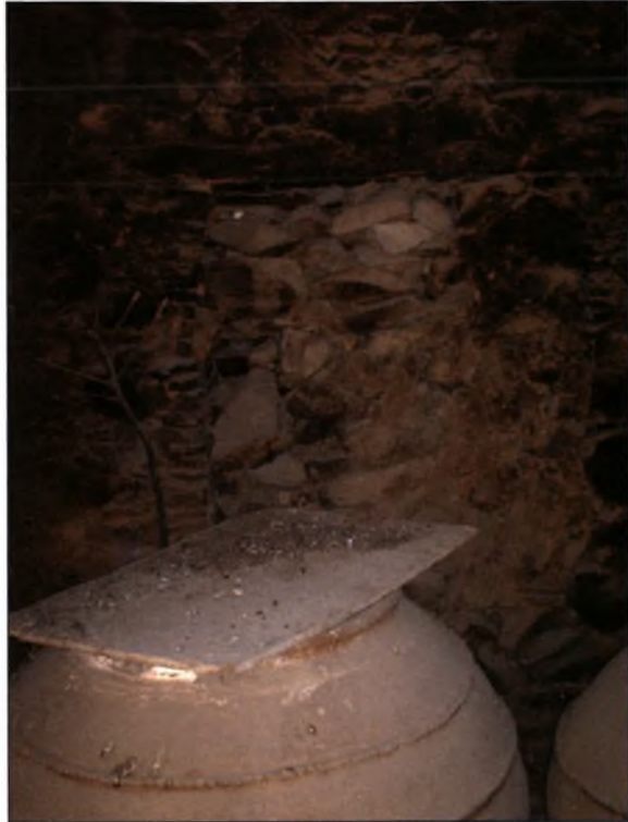
Εικόνα 62 : Φράξιμο ανοίγματος για να δεχτεί το καινούργιο κτίριο.
