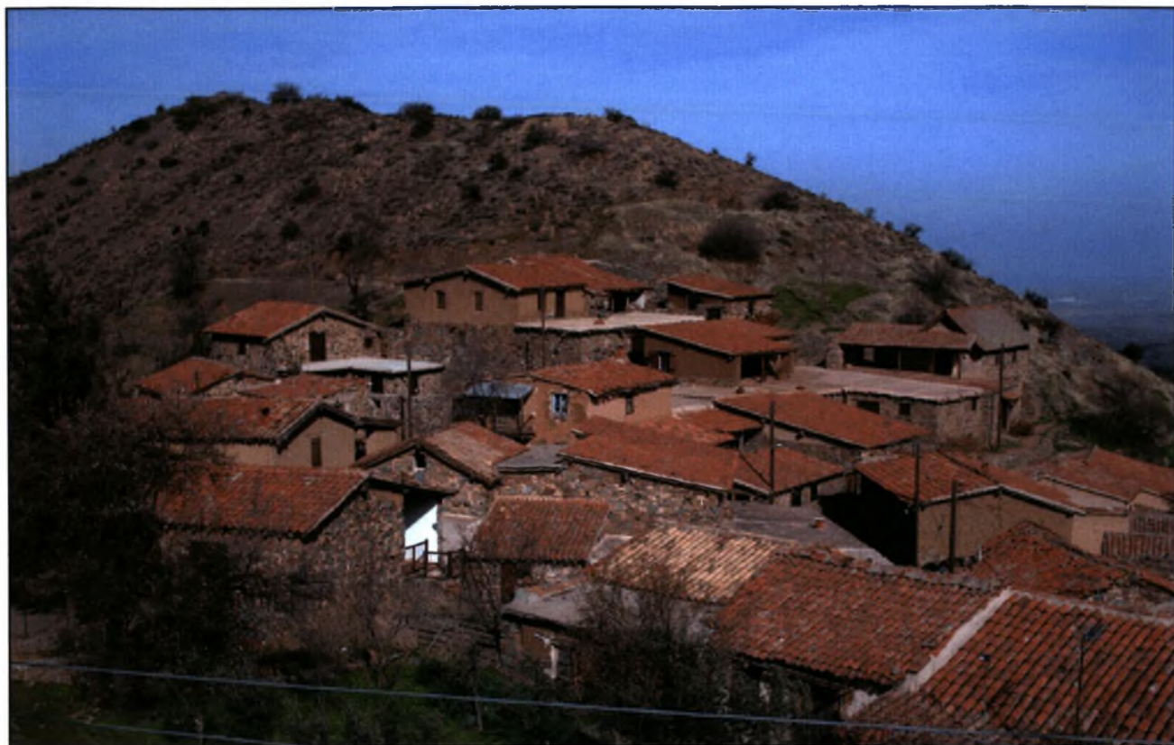
Εικόνα 14 : Άποψη του οικισμού με τις μονοκλιείς, δικλιείς και επίπεδες στέγες των σπιτιών.
