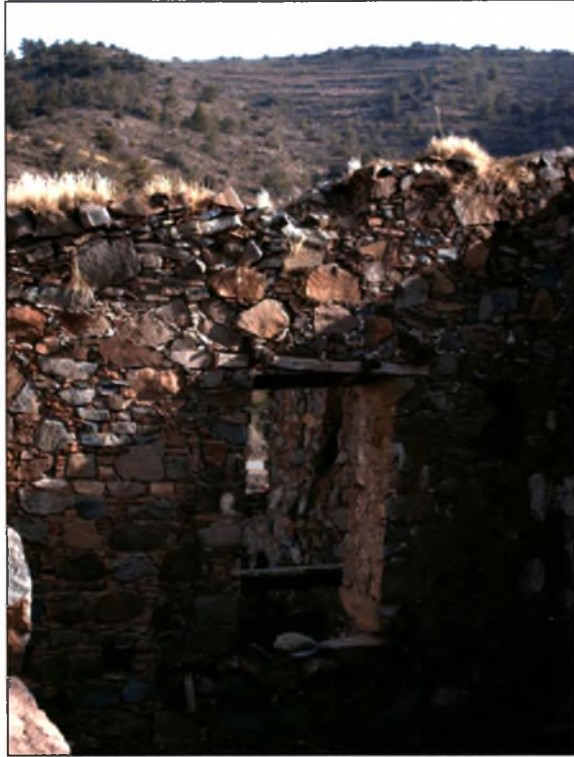
Εικόνα 92 : Καταστροφή στέγης, πατώματος και κουφωμάτων.
