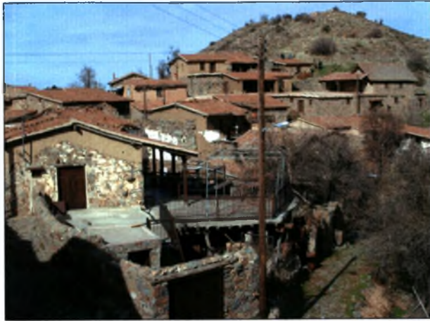
Εικόνα 25 : Είσοδοι των κτισμάτων .
