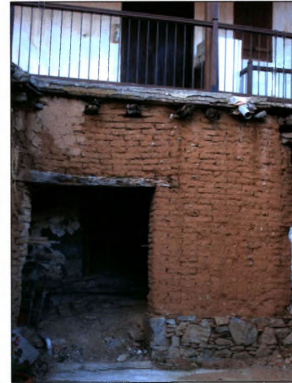
Εικόνα 72 : Παραμόρφωση που οφείλεται στα φορτία του ορόφου και της γήρανσης της ξυλείας.
