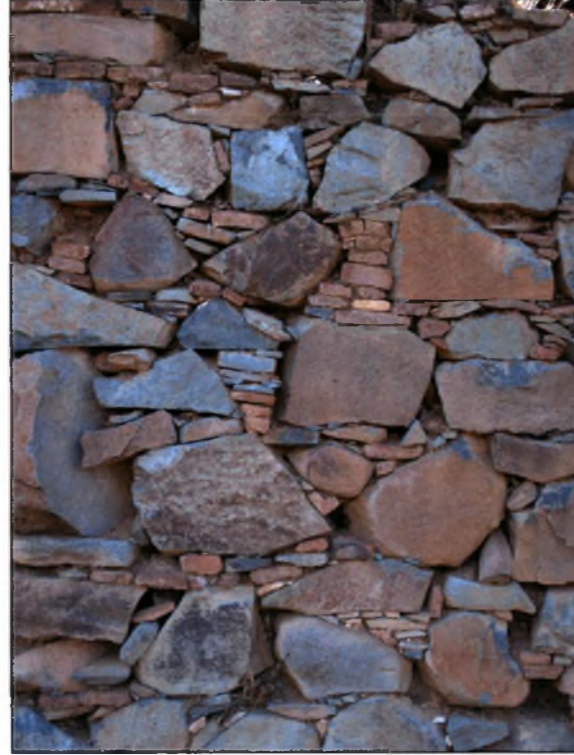
Εικόνα 80 : Επιφανειακή διάβρωση.
