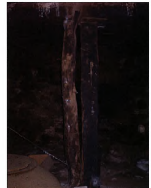
Εικόνα 32 : Εσωτερικός χώρος με την εγκατάσταση της τσιμινιάς. Οικία Ζαχαρίου Α.
