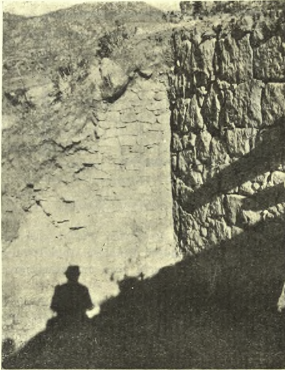
Εἰκ. 7. Τοῖχος ἐσωτερικοῦ δωματίου ἐν Ἐρρεσῷ.
