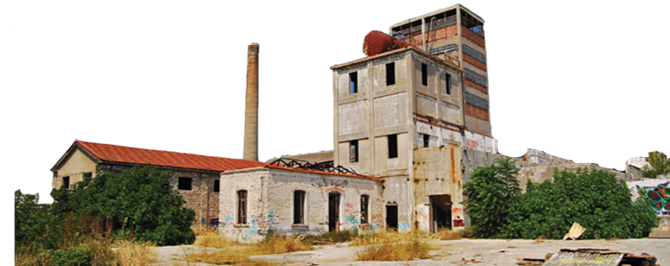
Πρώην ερχοστάσιο "Οινοπνεύματος".
