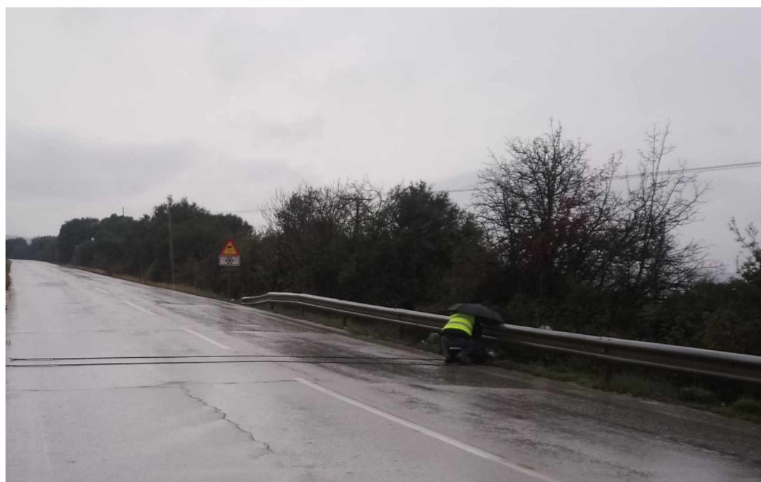
Εγκατάσταση Συσκευής Μέτρησης με Ανιχνευτές Πίεσης στο σημείο M1 στην ΕΟ 6 Ιωαννίνων-Ηγουμενίτσας
