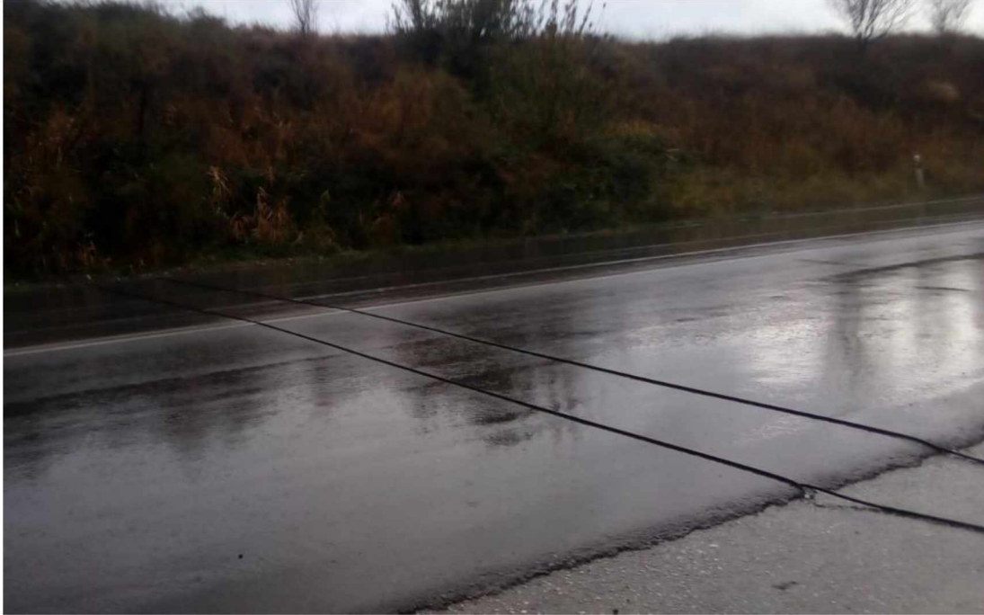
Εγκατάσταση Συσκευής Μέτρησης με Ανιχνευτές Πίεσης στο σημείο M7 ΕΟ2 Κομοτηνής – Αλεξανδρούπολης
