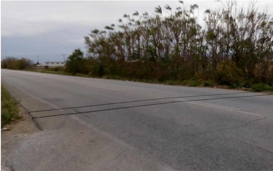
Εγκατάσταση Συσκευής Μέτρησης με Ανιχνευτές Πίεσης στο σημείο M8 ΕΟ2 Αλεξανδρούπολης – Κήπων
