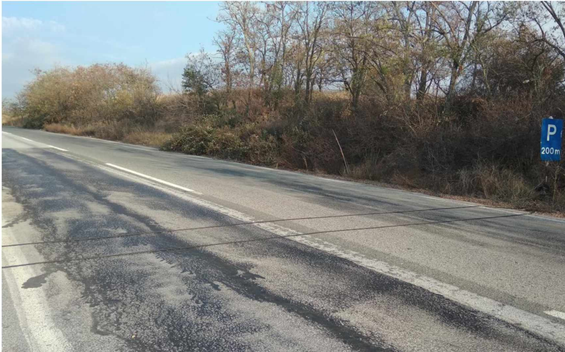
Εγκατάσταση Συσκευής Μέτρησης με Ανιχνευτές Πίεσης στο σημείο M5 ΕΟ12 Θεσσαλονίκης – Σερρών
