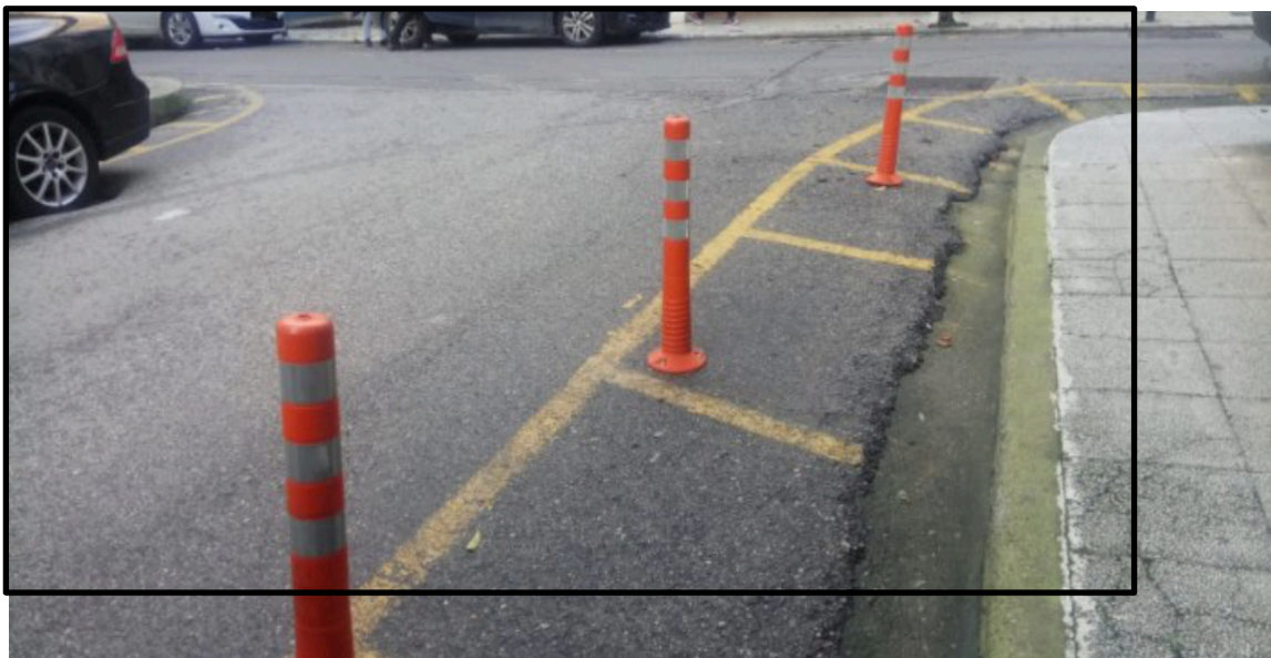
Εικόνα 9. Εύκαμπτα πλαστικά κολωνάκια δρόμου
