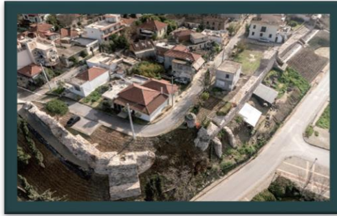
Εικόνα3.4: Τμήμα της βόρειας και δυτικής πλευράς της οχύρωσης Πηγή: Ντίνα, Αναστασιάδου «Το Κάστρο των Παλαιών»
