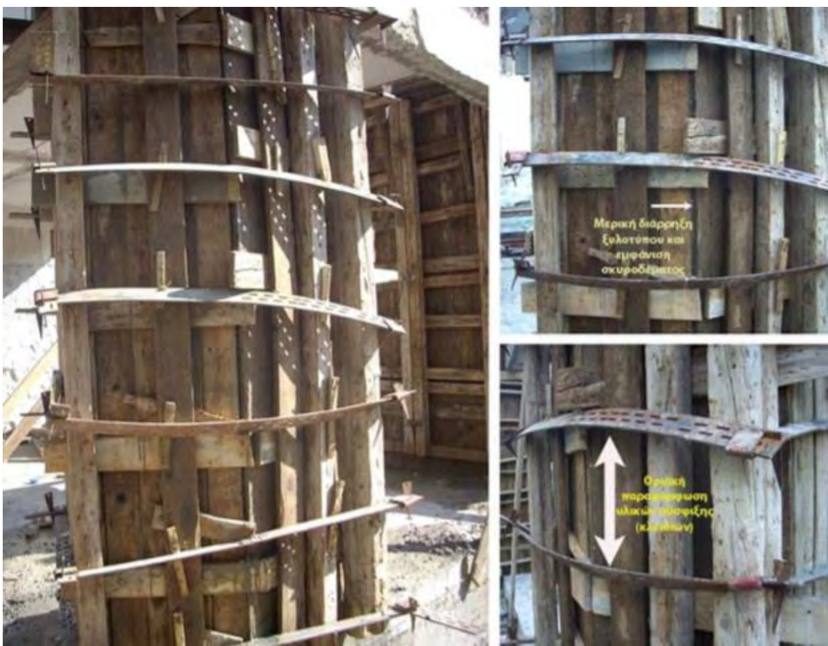
Εικόνα 6.1: Χρήση υλικών περίσφιξης στους ξυλότυπους του ΑΣΣ [πηγή: Γεωργιάδης (2009)]
