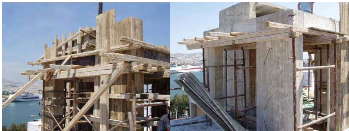
Εικόνα 7.2: Πριν (αριστερά) και μετά (δεξιά) την αφαίρεση των ξυλοτύπων [πηγή: Βογιατζής (2008)]
