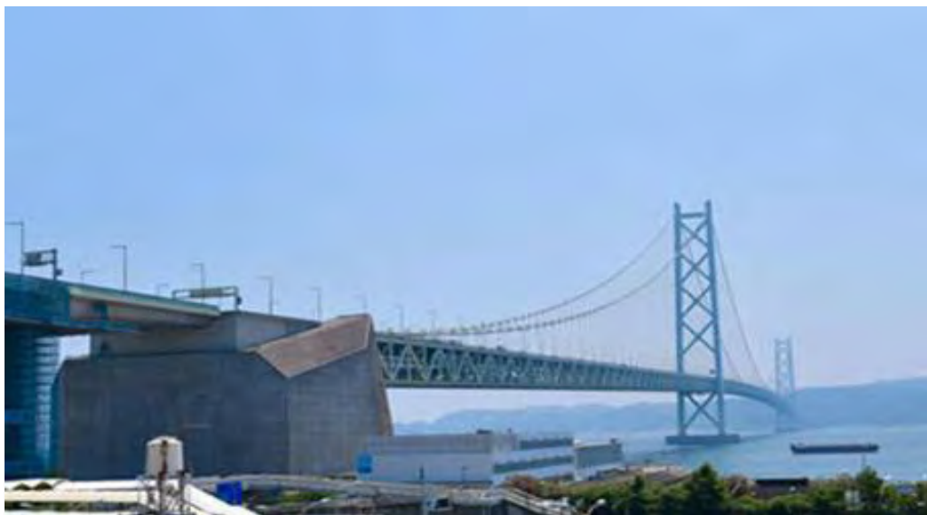
Εικόνα 2.2: Βάση αγκύρωσης γέφυρας Akashi-Kaikyo [πηγή: Ouchi (2003)]
