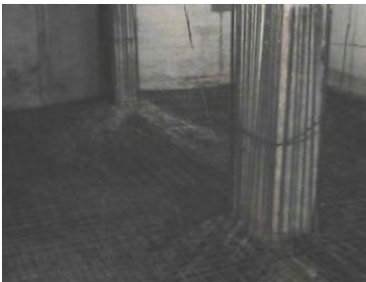
Εικόνα 7.1: Χαλύβδινος οπλισμός πριν από τη σκυροδέτηση [πηγή: Βογιατζής (2008)]
