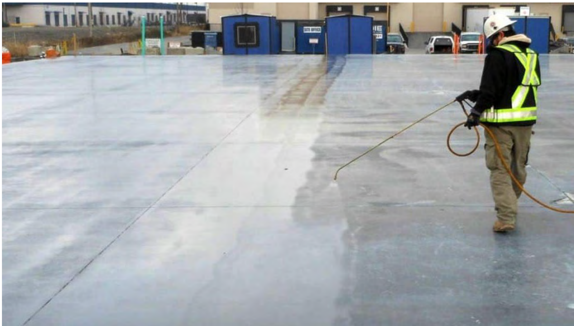
Εικόνα 4.10: Συντήρηση ελεύθερης επιφάνειας σκυροδέματος με διαβροχή [πηγή: https://civildigital.com/curing-concrete-purpose-curing-curing-methods/ ]
