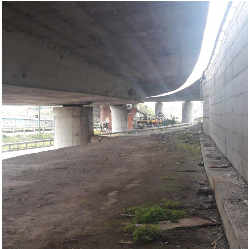
Εικόνα 7.5: Γέμισμα φορέα σε ανισόπεδο κόμβο Νέας Εθνικής Οδού Αθηνών-Πατρών [πηγή: Lafarge]
