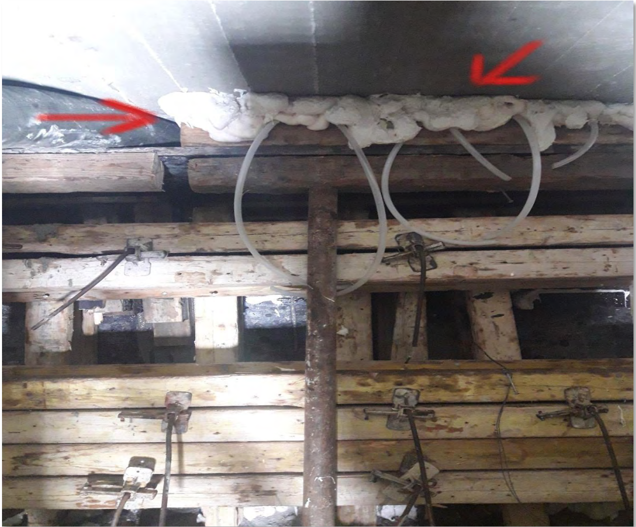
Εικόνα 6.2: Χρήση βαζελίνης (κόκκινο βέλος) και μεταλλικών ελασμάτων για στεγανότητα των ξυλοτύπων σε ανισόπεδο κόμβο στη Νέα Εθνική Οδό Αθηνών-Πατρών [πηγή: Lafarge]
