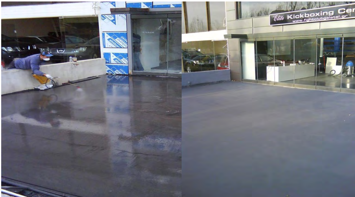
Εικόνα 7.3: Συντήρηση (αριστερά) και τελική επιφάνεια (δεξιά) δαπέδου ΑΣΣ στο Γαλάτσι
