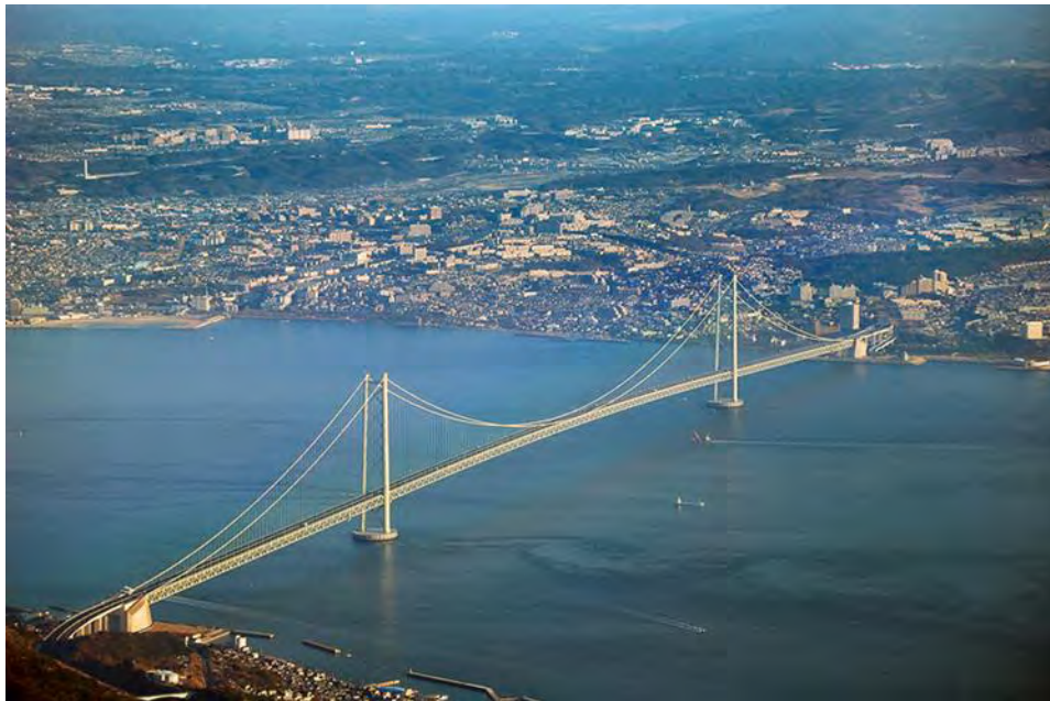
Εικόνα 2.1: Γέφυρα Akashi-Kaikyo [πηγή: Google Εικόνες]
