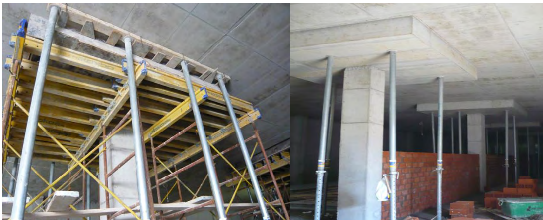
Εικόνα 7.4: Ενίσχυση υποστυλωμάτων στη Θεσσαλονίκη [πηγή: Lafarge]
