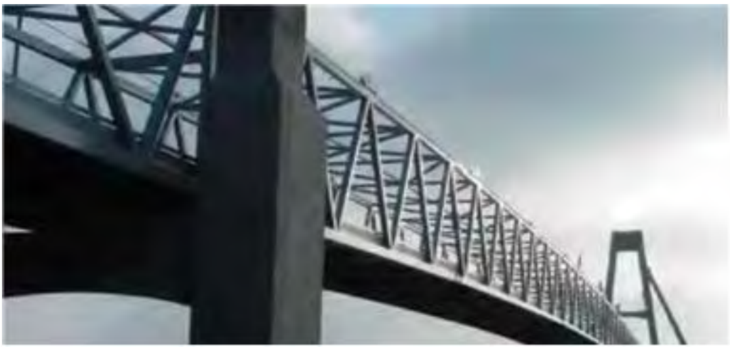
Εικόνα 2.4: Πεζογέφυρα στο Orlando, Florida [πηγή: https://assets.master-builders-solutions.com/en-us/project_profile-scc-overpass.pdf ]
