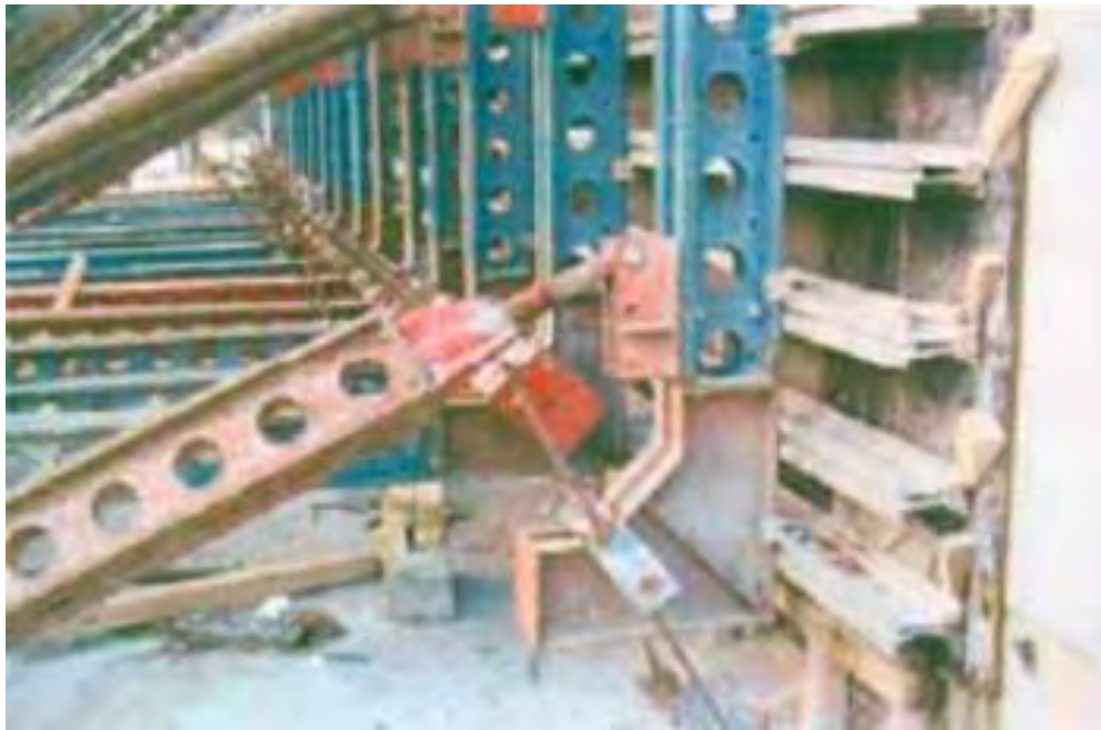
Εικόνα 4.9: Ξυλότυποι και μεταλλότυποι για κατακόρυφα στοιχεία [πηγή: Billberg et al. (2006)]
