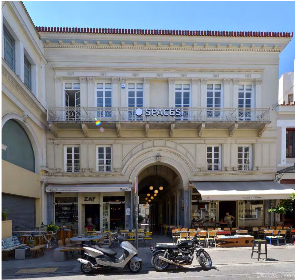
Το διατηρητέο νεοκλασικό μέγαρο και η Στοά Πύρρου, ως κτίριο συνεργατικών γραφείων, από την οδό Αθηναΐδος. Πηγή: www.snp.com.gr
