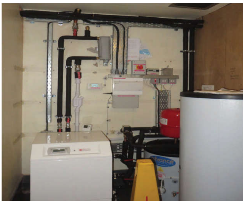
Σχήμα 4.8 Σύστημα θερμικής αντλίας νερού (WSHP) (ice publishing).
