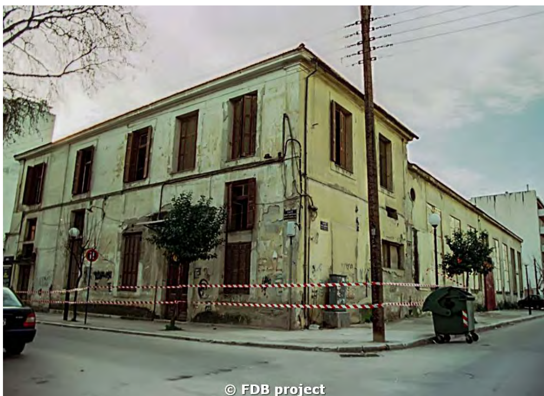
Εικόνα 3.3.7: Η όψη της Παλαιάς ηλεκτρικής το 1998, πριν την αποκατάσταση. [Πηγή: https://volospres.gr/palia-ilektriki-volou-fdb-15-2-1998/ last access 20/02/2020]
