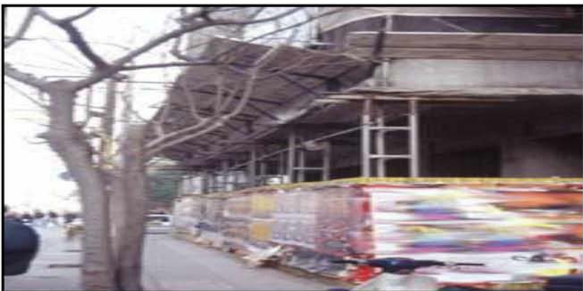
Εικόνα 3: Παράδειγμα περίφραξης κτηρίων (στην εικόνα βλέπουμε ότι έχει εκδοθεί άδεια κατάληψης του πεζοδρομίου και απαιτείται προστατευτικό στέγασμα.)
