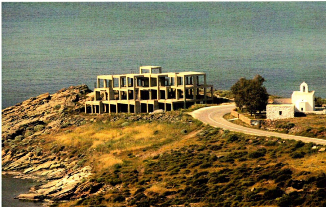
(Αυθαίρετη κατασκευή στη Τζιά)
