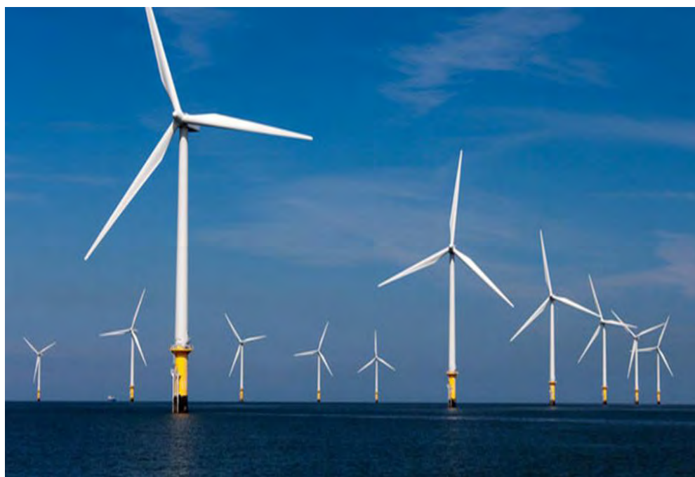
Σχήμα 2.10 : Θαλάσσιο αιολικό πάρκο στη Μεγάλη Βρετανία (Energypress).
