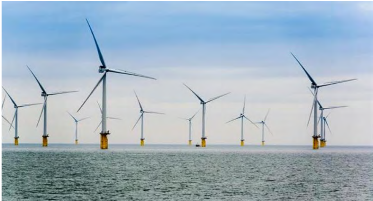
Σχήμα 2.11 : Υπεράκτιο αιολικό πάρκο Hornsea 1 (Orsted).
