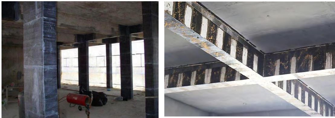
Σχήμα 2.12: Χρήση ινοπλισμένων πολυμερών για ενίσχυση υποστυλωμάτων και δοκών [16, 17].
