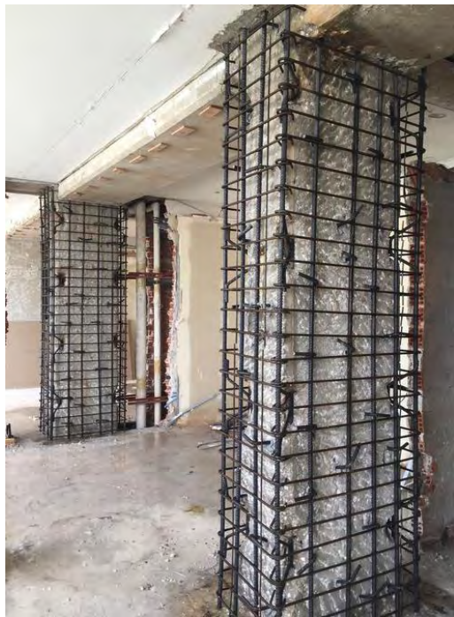
Σχήμα 2.10: Χρήση εκτοξευόμενου σκυροδέματος για κατασκευή μανδυών [14].
