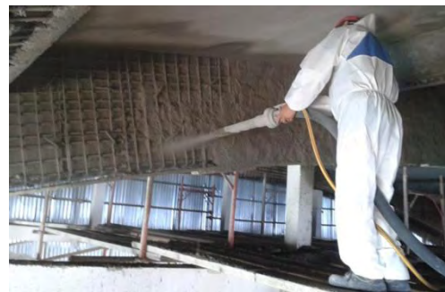
Σχήμα 2.10: Χρήση εκτοξευόμενου σκυροδέματος για κατασκευή μανδυών [14].
