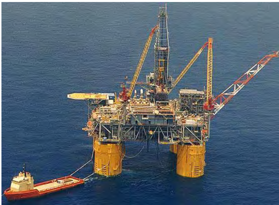
Εικόνα 67.Μεταφορά με ρυμούλκηση πλατφόρμας TLP.
