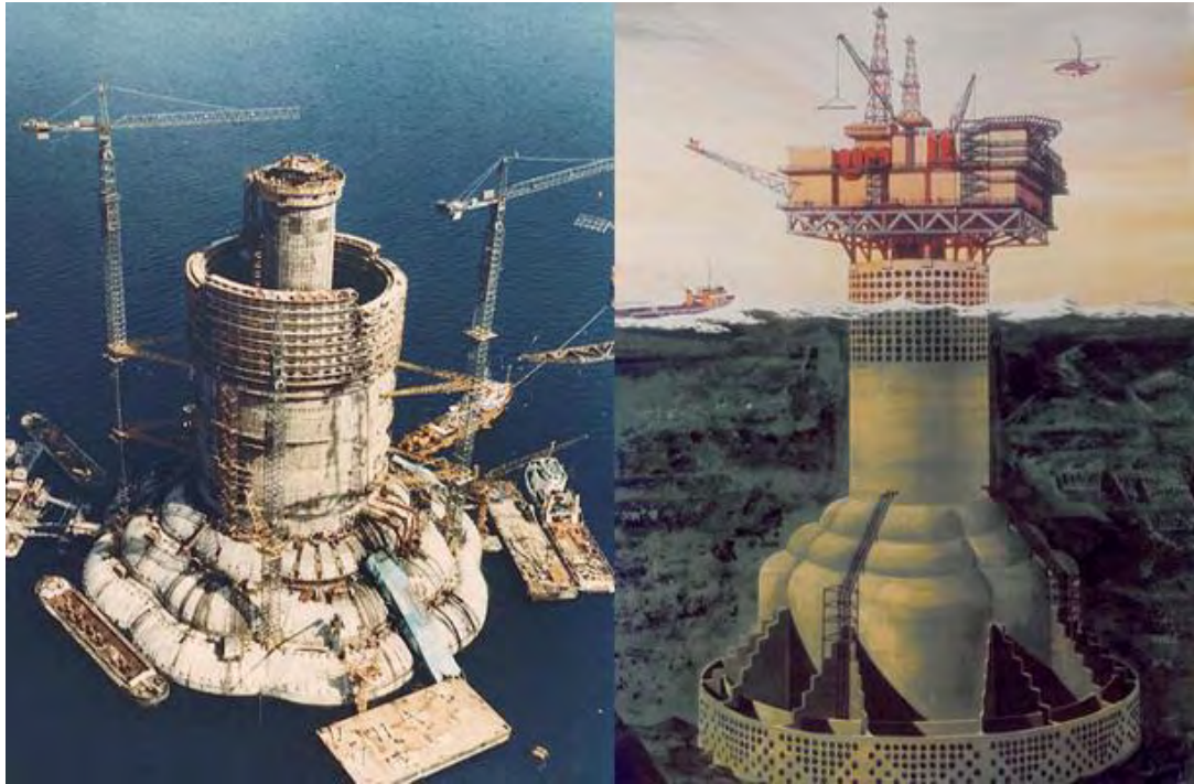
Εικόνα 60. Η πλατφόρμα Ninian κατά την κατασκευή της και το υποθαλάσσιο μέρος.
