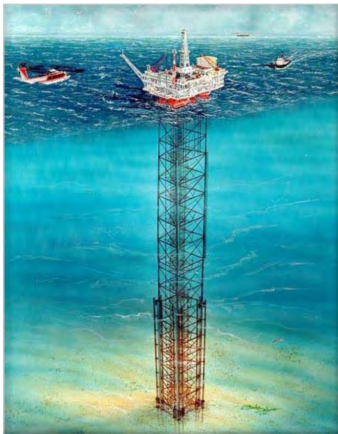
Εικόνα 59. Απεικόνιση της διάταξης ενός εύκαμπτου πύργου.
