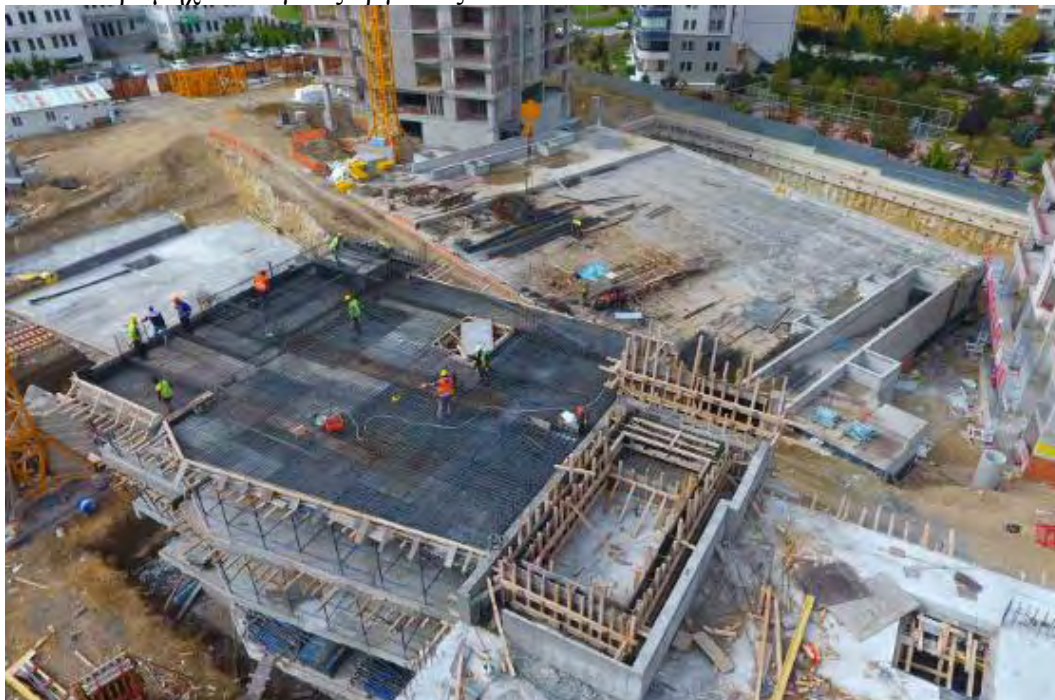
Σχήμα 2.1: Μικρό Εργοτάξιο Οικοδομικού Έργου
