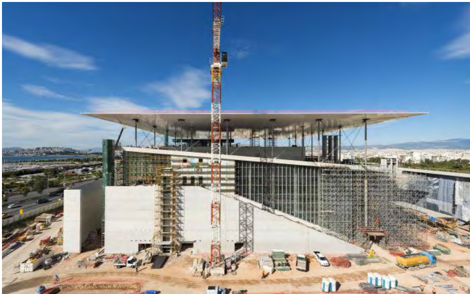
Σχήμα 2.4: Εργοτάξιο για την Κατασκευή του Ιδρύματος Σταύρος Νιάρχος
