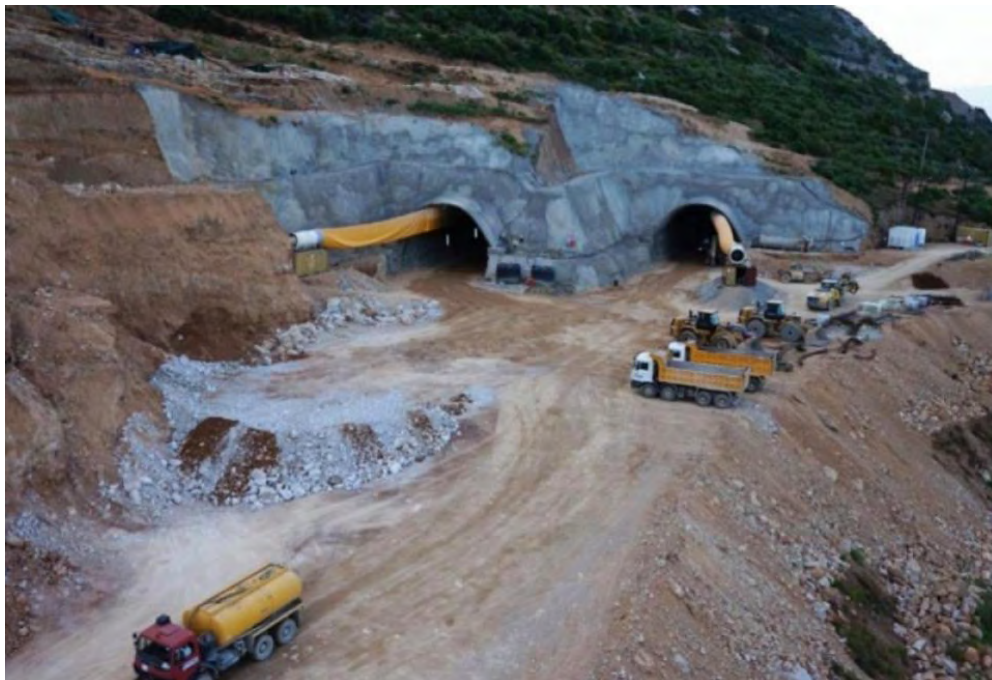
Σχήμα 2.6: Κατασκευή Οδικού Δικτύου με Διάνοιξη Σηράγγων
