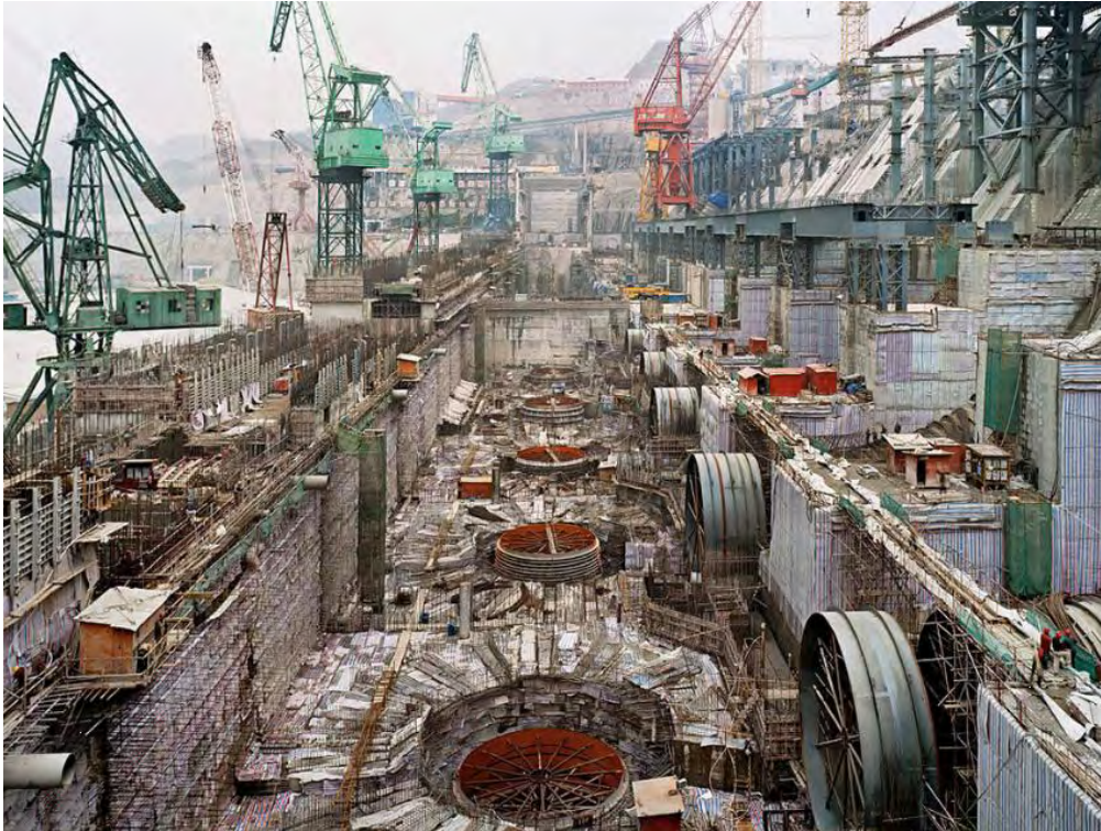
Σχήμα 2.2: Κατασκευή του Φράγματος Three Gorges Dam στην Κίνα.
