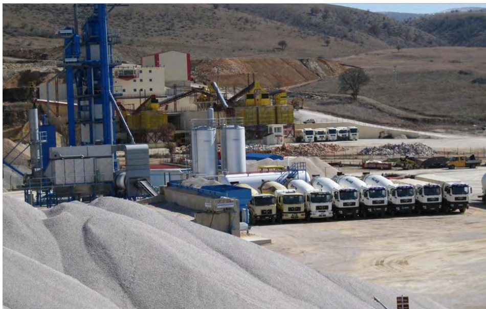
Σχήμα 2.14: Μονάδα παραγωγής ασφαλτοσκυροδέματος
