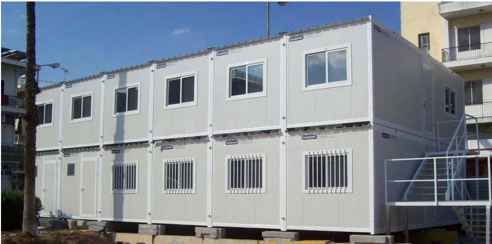
Σχήμα 2.25: Γραφεία Εργοταξίου Σταθμός Πειραιά
