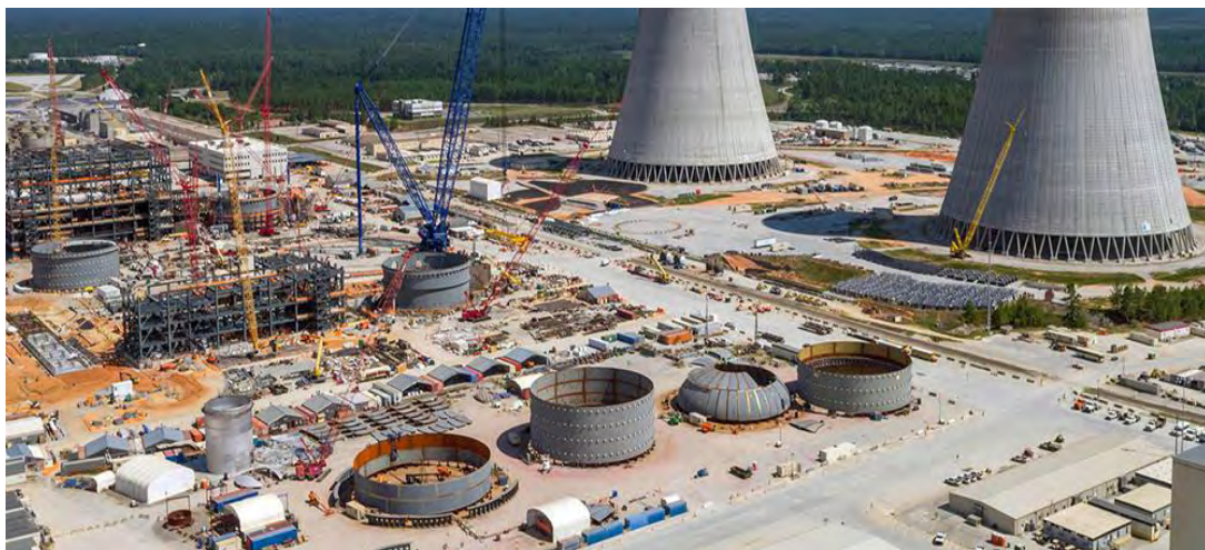
Σχήμα 2.3: Κατασκευή Αντιδραστήρων στην Περιοχή Waynesboro , USA .
