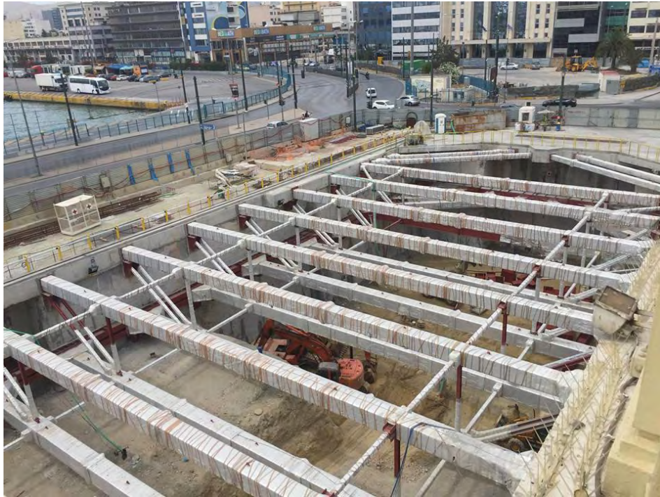
Σχήμα 2.9: Αντηρίδες στο Εργοτάξιο Σταθμός Πειραιά στην Αθήνα.
