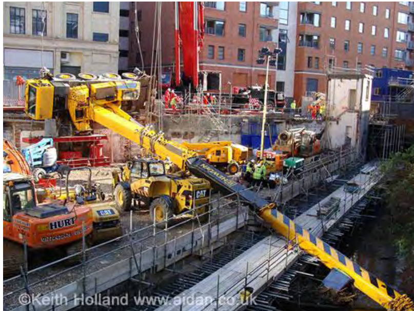
Σχήμα 2.27: Ανατροπή Μηχανήματος.
