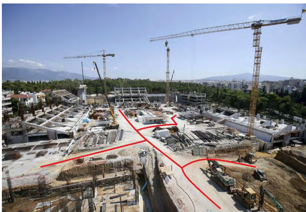
Σχήμα 2.10: Οδικό Δίκτυο εντός του Εργοταξίου του Γηπέδου Αγία Σοφία (Με Κόκκινη Διαγράμμιση)
