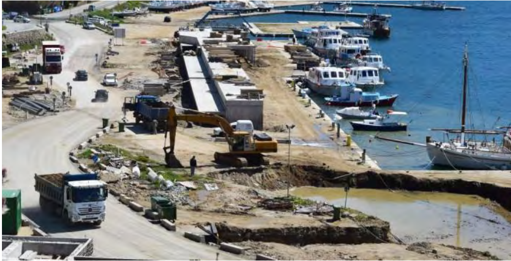
Σχήμα 2.7: Εργοτάξιο Κατασκευής Λιμανιού
