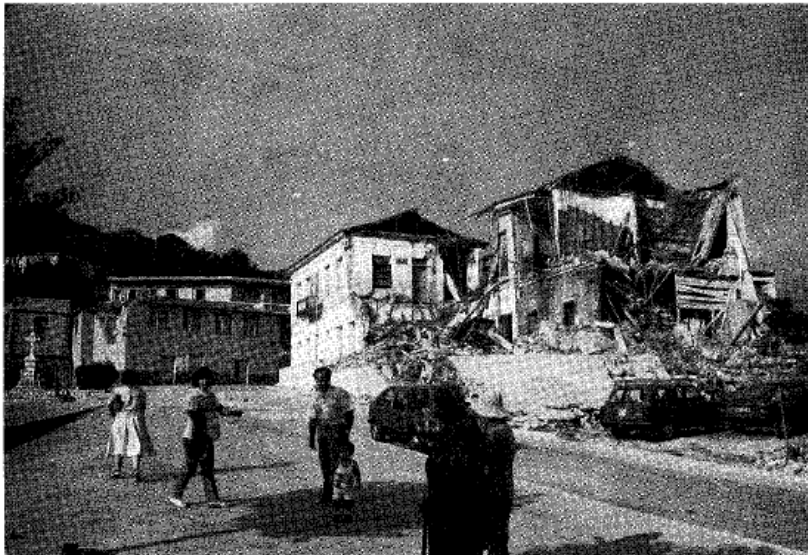
Σχήμα 1.2.6: Κατάρρευση παλιού πέτρινου κτιρίου στην Καλαμάτα (Anagnostopoulos et al, 1987)
