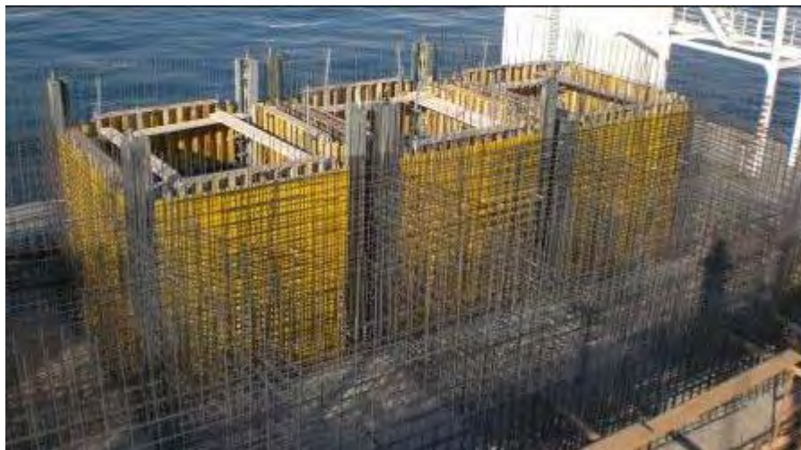
Σχήμα 1.3.2: Κατασκευή κυψελωτού κρηπιδοτοίχου στο λιμάνι του Πειραιά (Πηγή: https://www.archimedes-sa.com )
