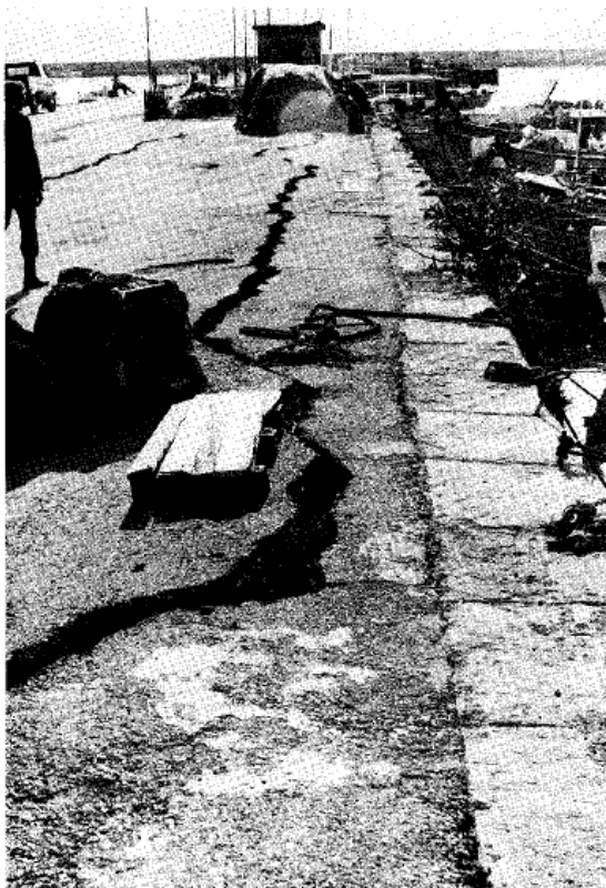
Σχήμα 1.2.5: (α) Αποκόλληση του λιμενικού κρηπιδοτοίχου από το αντιστηριζόμενο έδαφος (Anagnostopoulos et al, 1987), (β) Μόνιμες μετακινήσεις κρηπιδοτοίχου (Pitilakis & Moutsakis, 1989)
