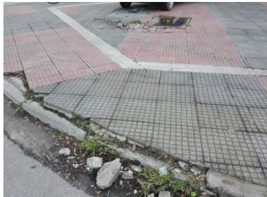
Εικόνα 25: Γωνία διασταύρωσης οδών Ζάχου - Γρηγορίου Λαμπράκη
