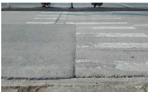
Εικόνα 8: Φωτογραφία διάβασης πεζών σε παραμελημένη κατάσταση (αριστερά) και μετά από πρόσφατη διαγράμμιση (δεξιά)
