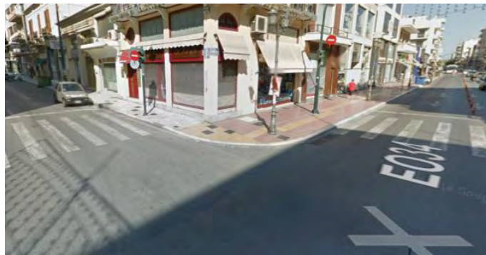
Εικόνα 4: Σκάφη πεζοδρομίου που εξυπηρετεί δύο διαβάσεις στη διασταύρωση δύο κύριων οδών, Δημητριάδος-Ελ. Βενιζέλου (Google maps)
