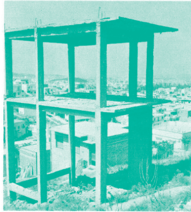
55. Ό κατασκευαστικός τύπος του Dom-ino, Le Corbusier, 1914.
