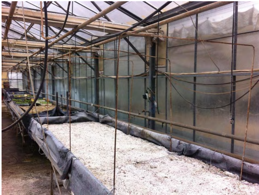
Εικόνα 2.2-4 Τμήματα του σκελετού που έχουν στερεωθεί
