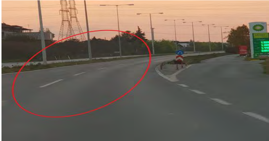
Καμπύλη με αρνητική επίκλιση στην κατεύθυνση προς Τρίκαλα
