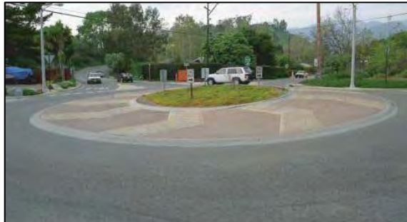
Εικόνα 5.28 Ειδική επίστρωση υπερβατής ζώνης με σχηματισμό βελών [24]
