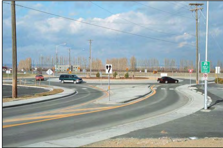
Εικόνα 5.1 Παράδειγμα χρήσης της γεωμετρίας για διαχείριση της ταχύτητας των οχημάτων [24]
