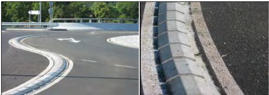
Εικόνα 3.24 Υπερυψωμένο διαχωριστικό λωρίδων σε σπειροειδή K^3 [35]
