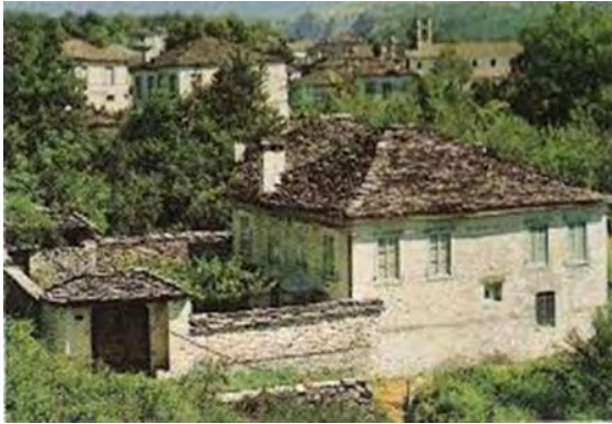
Εικόνες 18-19: Η ζαγορίσια κατοικία εξωτερικά (18) (Πηγή: Κοντογιάννη, 2006)
