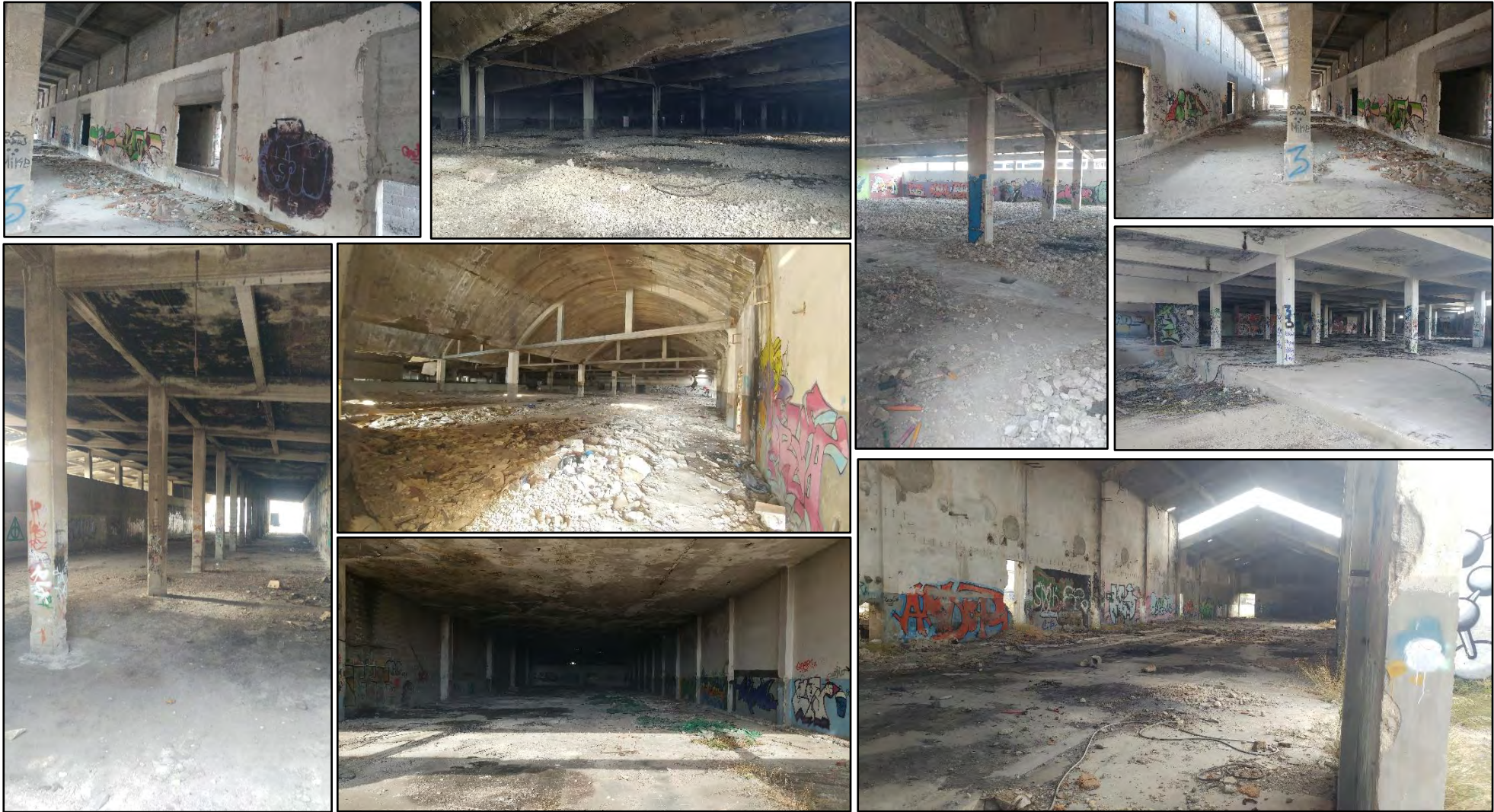
Εικόνα 4.14: Εσωτερικά κελύφη «Βαμβακουργίας». Πηγή: προσωπικό αρχείο
