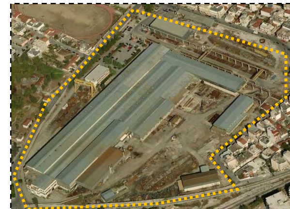
Εικόνα 4.10: Ενεργό εργοστάσιο ΜΕΤΚΑ δίπλα από την περιοχή μελέτης. Πηγή: Bing maps
