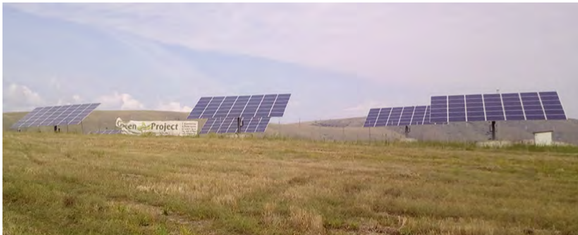
Σχήμα 2.3: Η εγκατάσταση του φωτοβολταϊκού πάρκου
