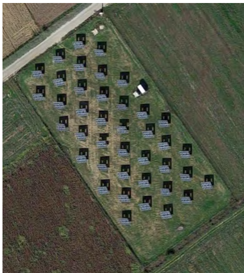
Σχήμα 2.1: Φωτογραφία δορυφόρου της εγκατάστασης [11]
