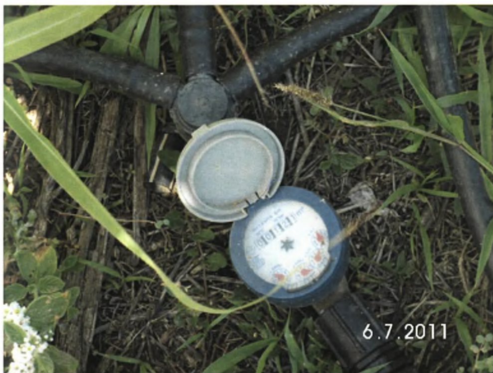
Εικόνα 2.6. Υδρομετρητής
