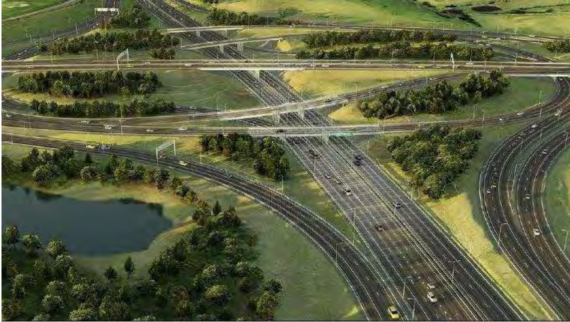
Εικόνα 16 M25 highway (πηγή : http://aerialadvantage.com.au/ )
