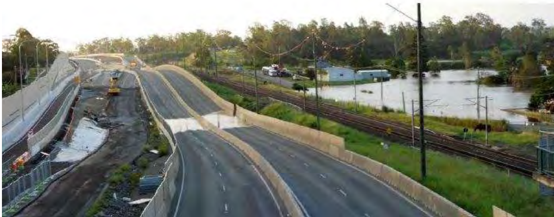
Εικόνα 15 Καταστροφές που προκλήθηκαν στον αυτοκινητόδρομο Ipswich ( http://www.flickr.com )
