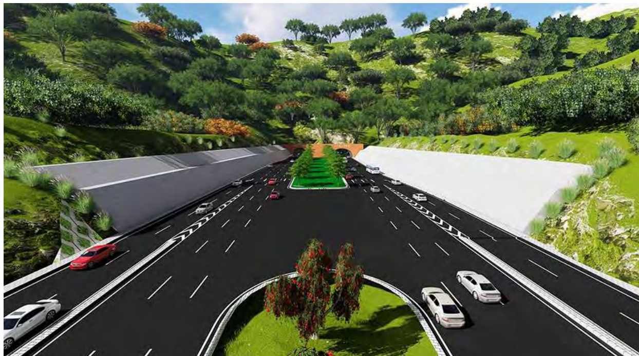
Εικόνα 10 Άποψη του τμήματος Huayan Interchange (πηγή : https://www.autodesk.com/solutions/bim/hub/aec-excellence-2018/infrastructure/large )
