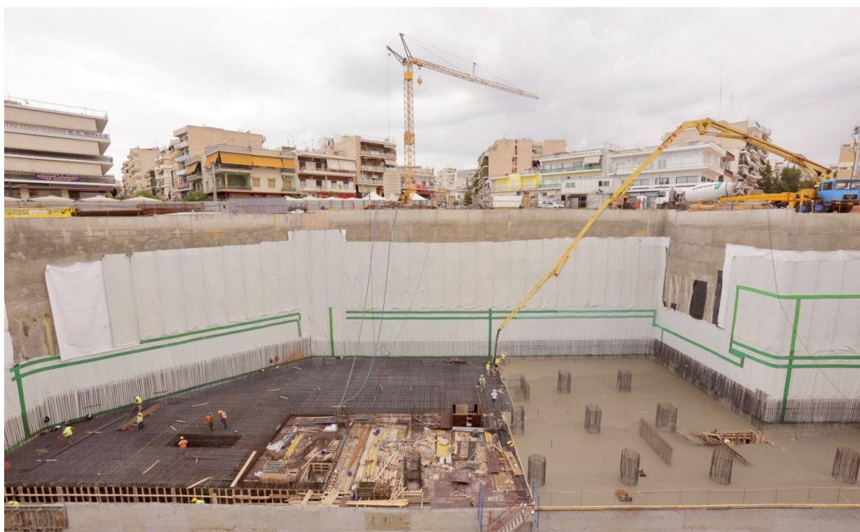
ΦΩΤΟ 8:: ΣΚΥΡΟΔΕΤΣΗ ΠΛΑΚΑΣ ΕΠΙΠΕΔΟΥ ΑΠΟΒΑΘΡΩΝ - 2014
