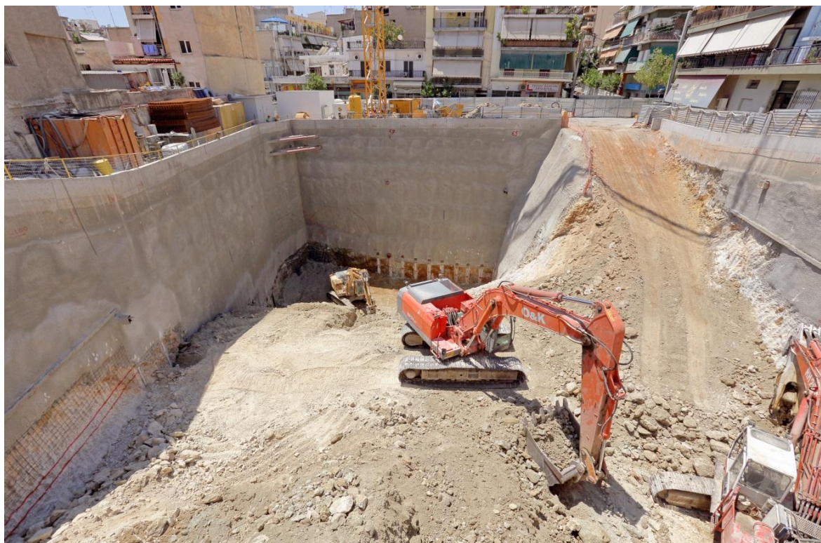
ΦΩΤΟ 19: ΕΚΣΚΑΦΗ ΑΝΟΙΚΤΟΥ ΟΡΥΓΜΑΤΟΣ ΣΤΑΘΜΟΥ - 2014
