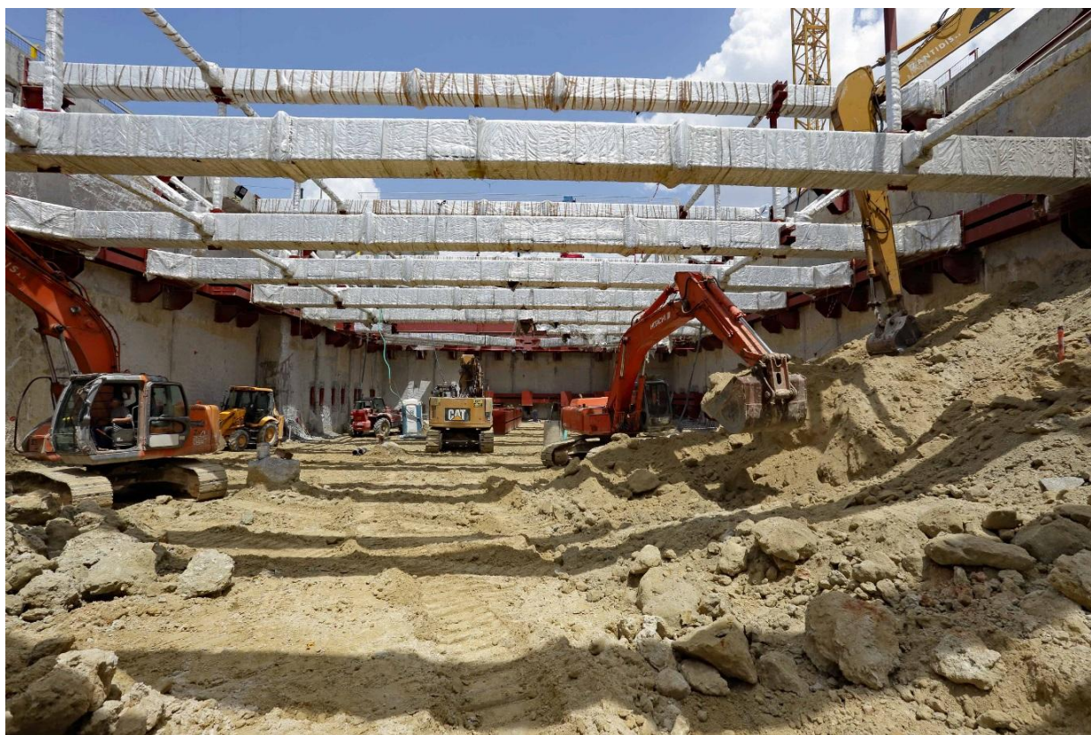
ΦΩΤΟ 28: ΕΡΓΑΣΙΕΣ ΕΚΣΚΑΦΗΣ 3 ΗΣ ΣΤΑΘΜΗΣ ΑΝΟΙΧΤΟΥ ΟΡΥΓΜΑΤΟΣ - 2018
