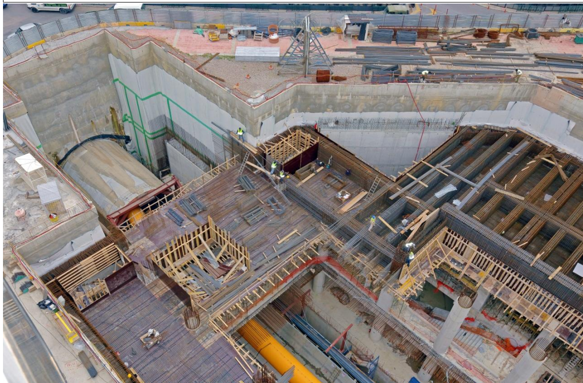
ΦΩΤΟ 9: ΕΡΓΑΣΙΕΣ ΚΑΤΑΣΚΕΥΗΣ ΚΑΤΩ ΠΛΑΚΑΣ ΟΡΟΦΗΣ – 2015
