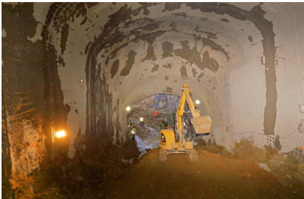
ΦΩΤΟ 20: ΑΠΟΨΗ ΕΡΓΑΣΙΩΝ ΘΑΛΑΜΟΥ ΠΡΟΣΒΟΛΗΣ ΣΗΡΑΓΓΑΣ ΝΑΤΜ ΣΤΑΘΜΟΥ - 2014
