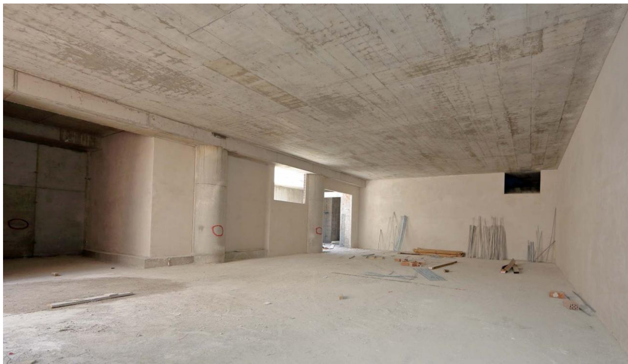
ΦΩΤΟ 4: ΑΠΟΨΗ ΕΠΙΧΡΙΣΜΑΤΩΝ ΕΠΙΠΕΔΟΥ ΜΗΧΑΝΟΛΟΓΙΚΟΥ ΟΡΟΦΟΥ - 2016
