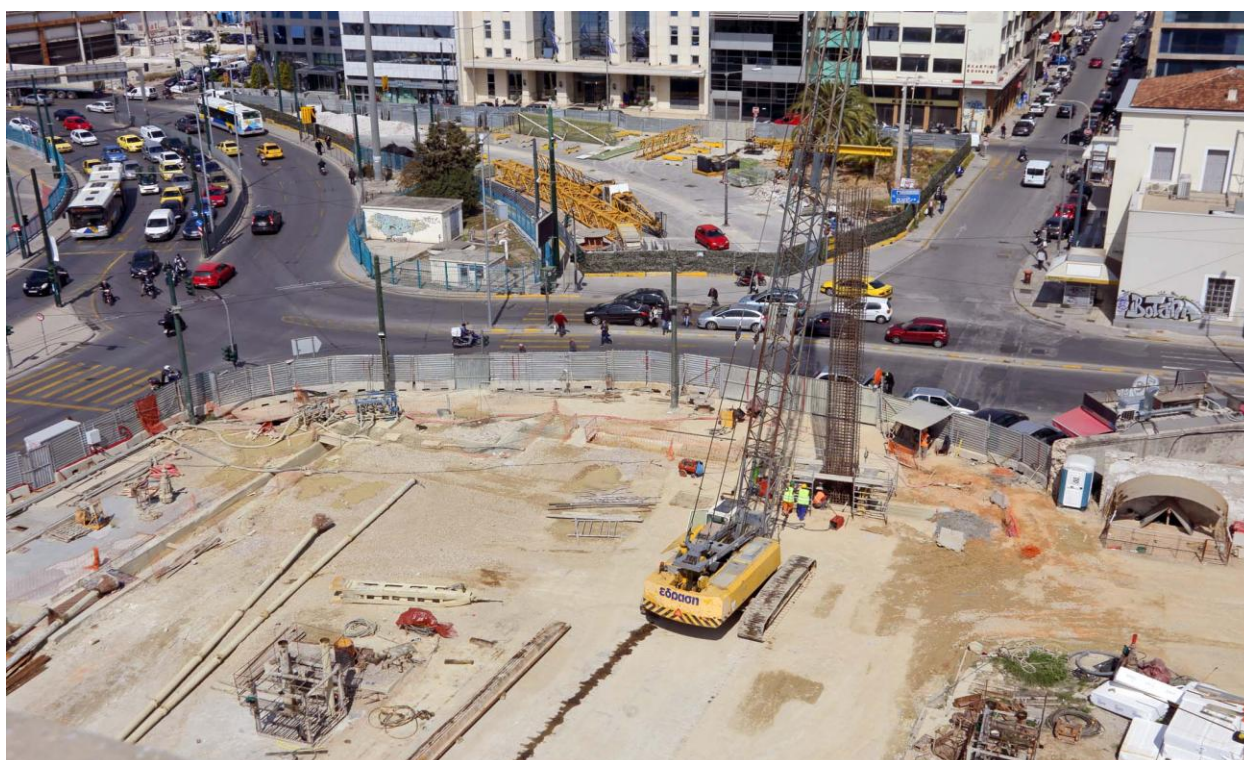
ΦΩΤΟ 26: ΤΟΠΟΘΕΤΗΣΗ ΣΙΔΗΡΟΥ ΟΠΛΙΣΜΟΥ ΔΙΑΦΡΑΓΜΑΤΙΚΟΥ ΤΟΙΧΟΥ - 2016
