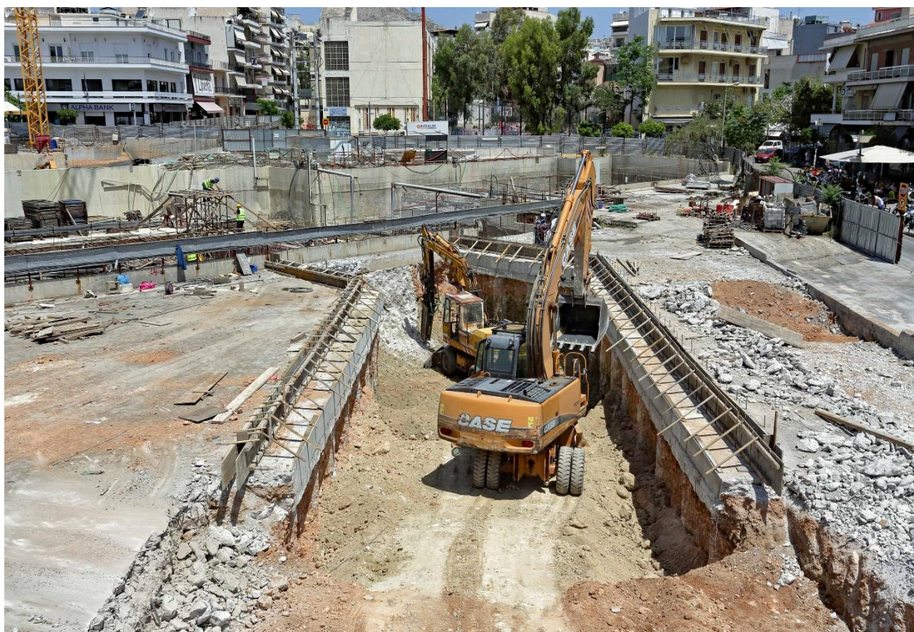
ΦΩΤΟ 12: ΕΡΓΑΣΙΕΣ ΕΚΣΚΑΦΗΣ ΠΡΩΤΗΣ ΣΤΑΘΜΗΣ (ΠΕΡΙΟΧΗ ΠΡΟΣΒΑΣΗΣ Νο.1) - 2018
