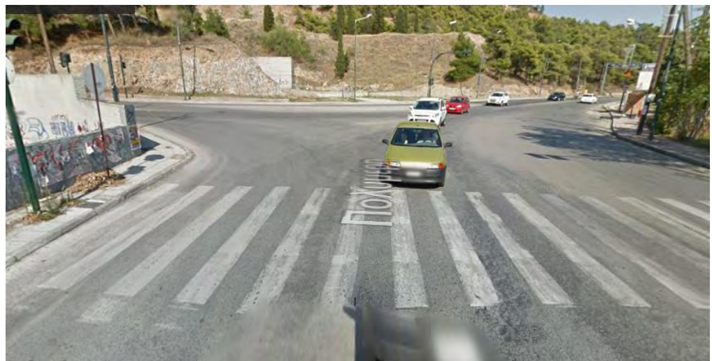
Εικόνα 8-3: Όψη του υπό μελέτη κόμβου
