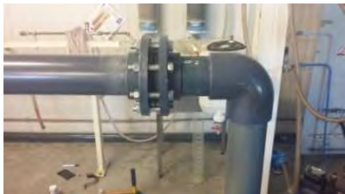
51. Φλάντζες πριν τη γωνία
