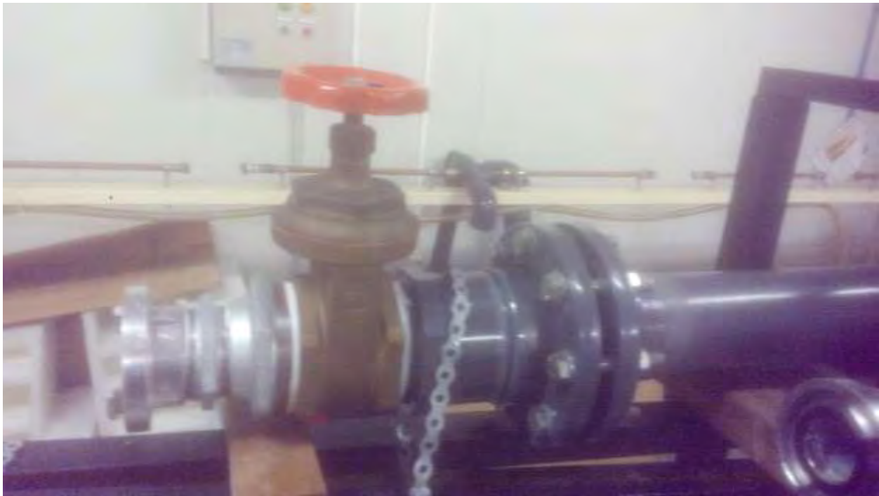
110. Αντάπτορας σύνδεσης με το λάστιχο του πυροσβεστικού για το δίκτυο Φ110 (4'')
