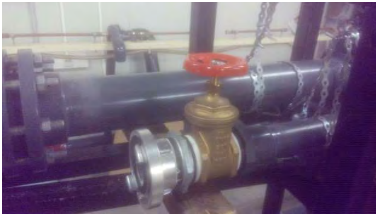
122. Αντάπτορας σύνδεσης με το λάστιχο του πυροσβεστικού για το δίκτυο Φ63(2.5'')
