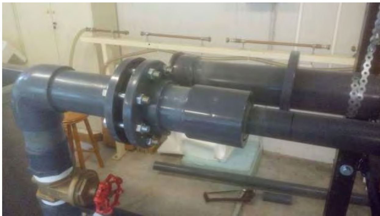
107. Σύνδεση του αγωγού Φ63 (2.5") για δοκιμή του δικτύου
