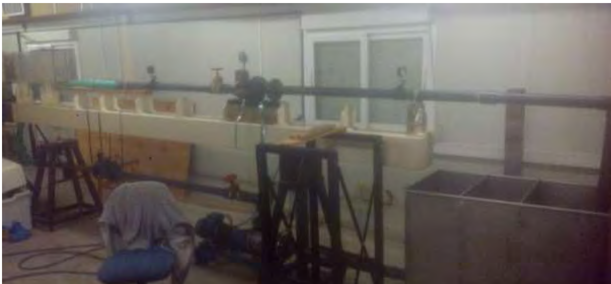
99. Το πλήρες δίκτυο αγωγού Φ63 (2.5'') εγκατεστημένο
