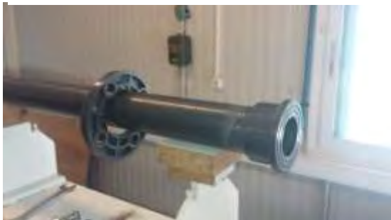
98. Τοποθέτηση φλάντζας για σύνδεση με PAT
