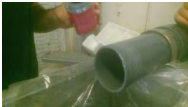
38. Πλήρης επάλειψη της σωλήνας με κόλλα
