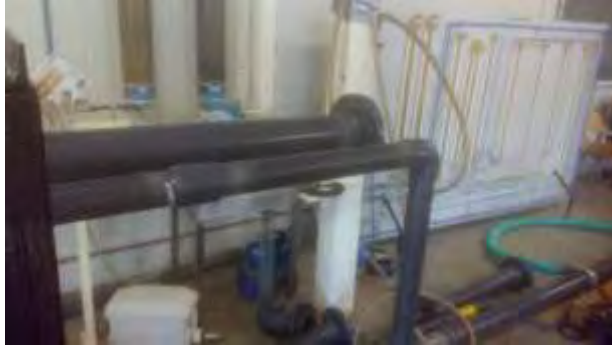
70. Κόλληση γωνίας στην αγωγή Φ63
