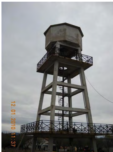
Εικόνα 2-3 : Δεξαμενή νερού σε αυξημένη υψομετρική θέση
