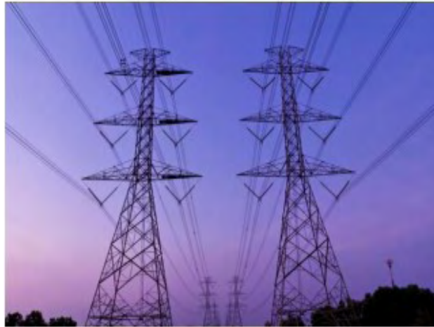
Εικόνα 1.1: Γραμμές μεταφοράς ηλεκτρικής ενέργειας
