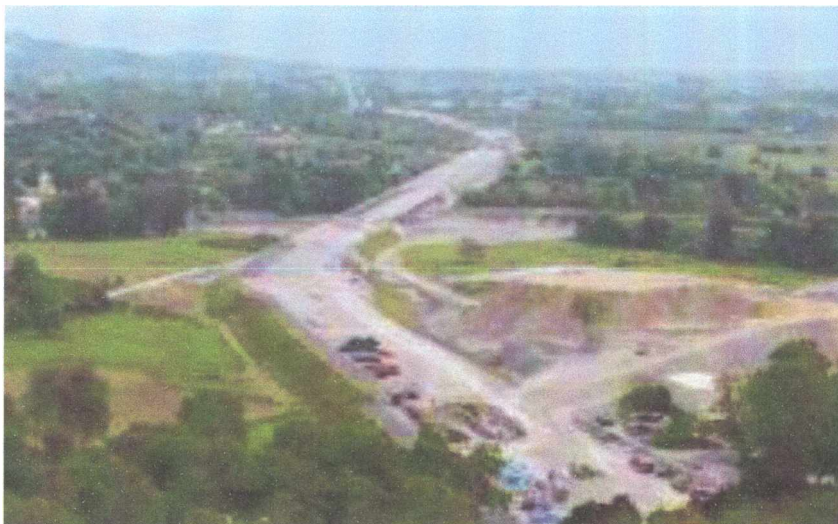
Εικόνα 4.6 Κατασκευή ανοιχτής οδοποιίας
