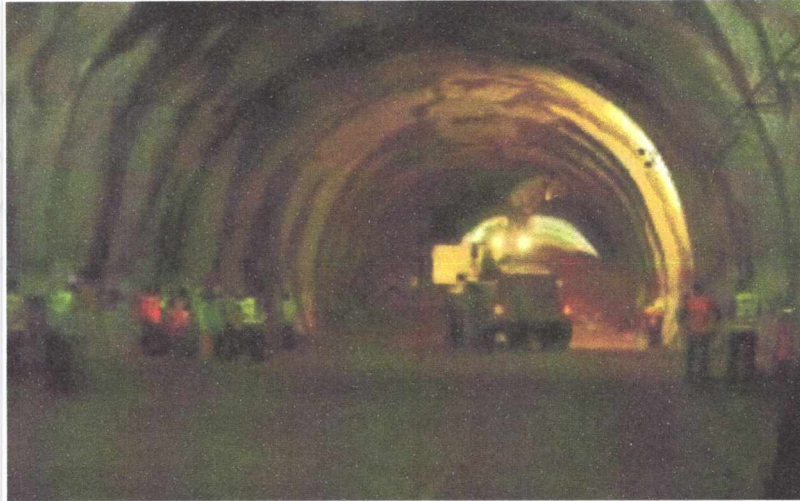
Εικόνα 4.4 Διάνοιξη σήραγγας T2
