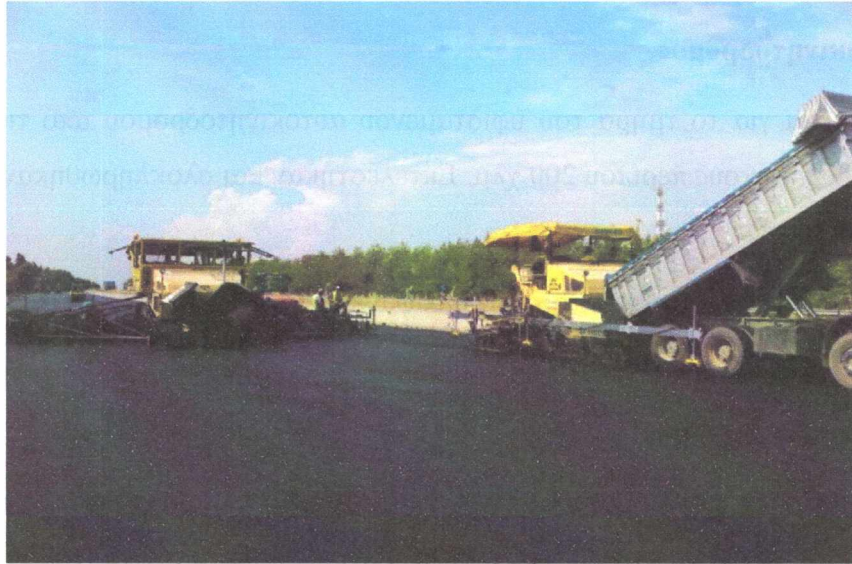
Εικόνα 4.1 Διάστρωση ασφαλτοτάπητα
